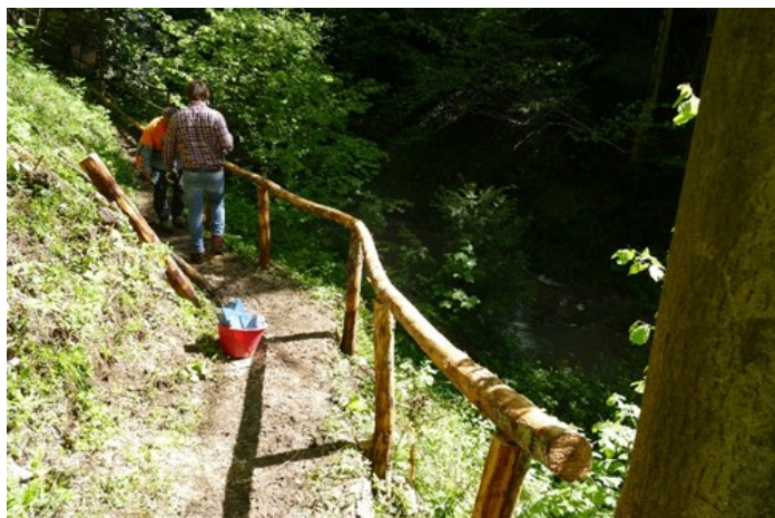
Rifacimento staccionata – operai ERSAF al lavoro
