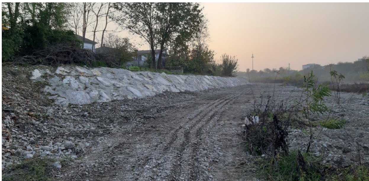
Foto 3 - Sistemazione scogliera esistente
