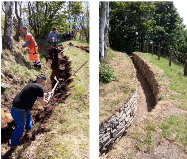
Pulizia trincee percorso «L.M. Belloni»
