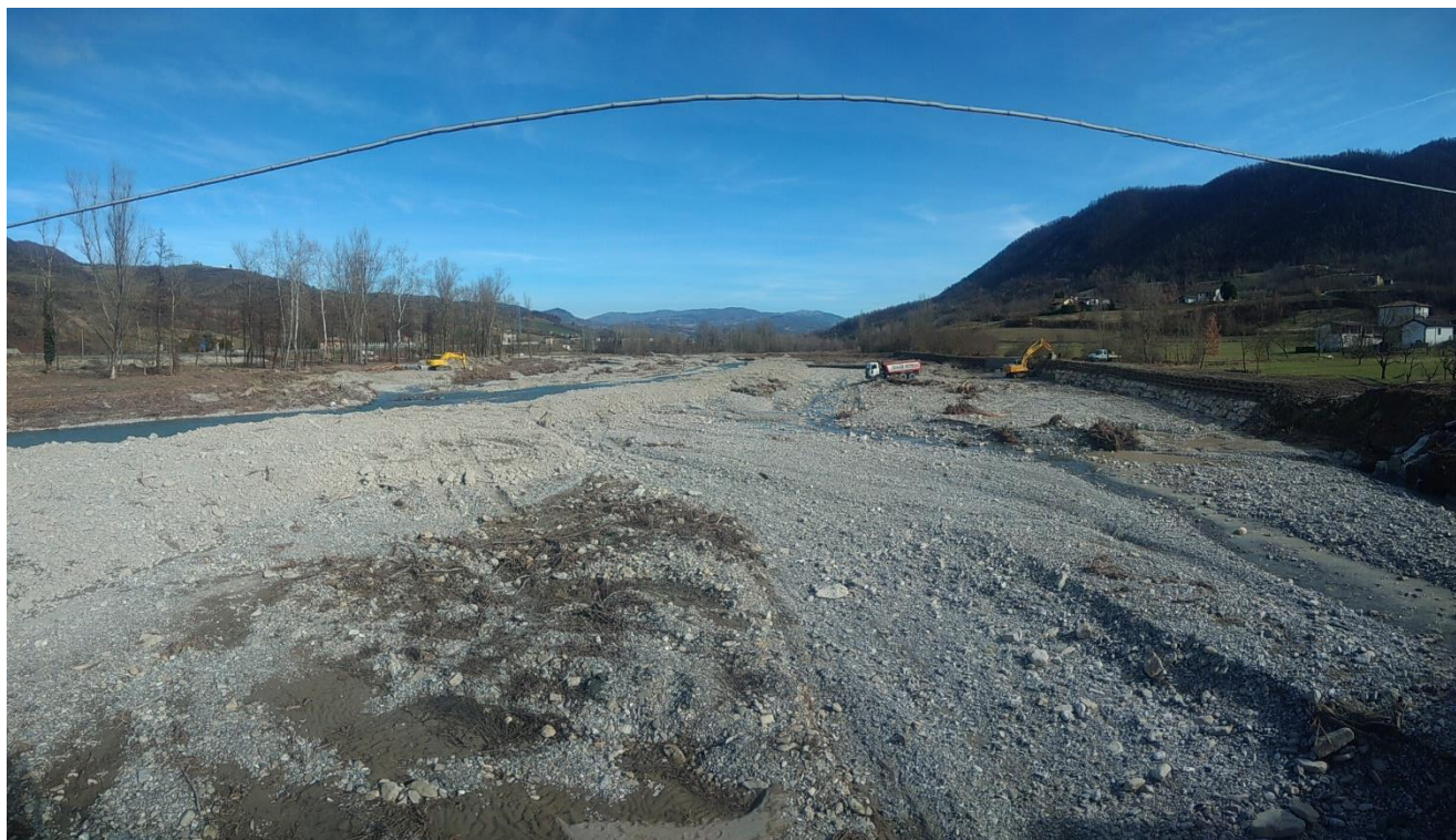
Figura 6 scogliera in sponda sx e secondo canale
