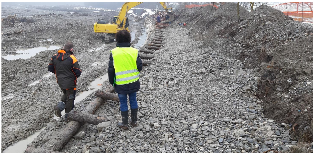
Figura 4 consolidamento della sponda
