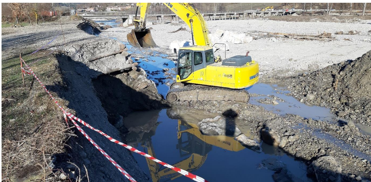
Figura 3 lavori lungo la sponda
