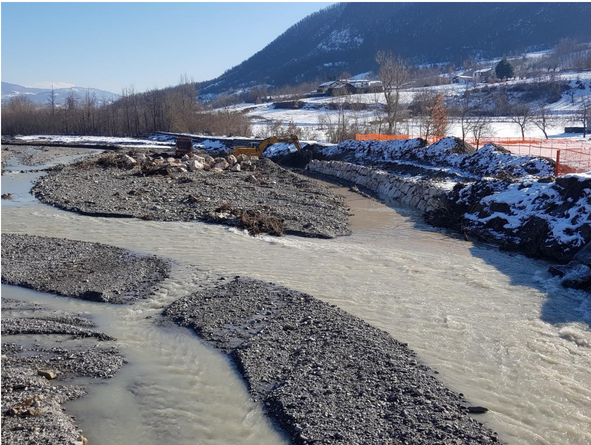
Figura 1 consolidamento delle sponde
