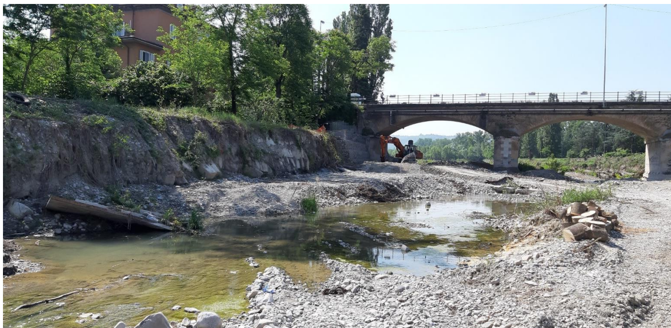
Foto 3 e 4 - Lavori di posizionamento dei gabbioni
