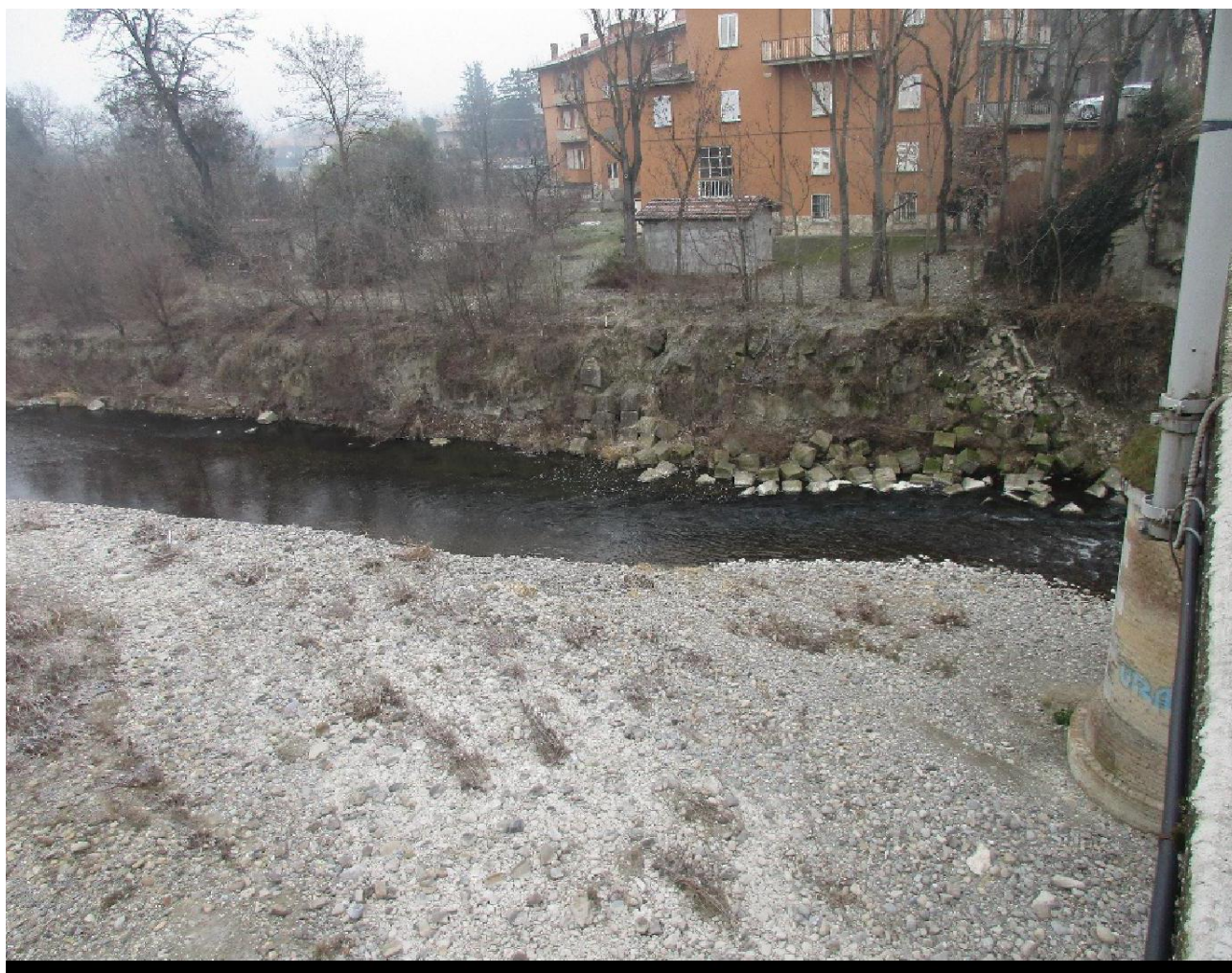
Foto 2 - Vista della scogliera in blocchi di cls prima dei lavori
