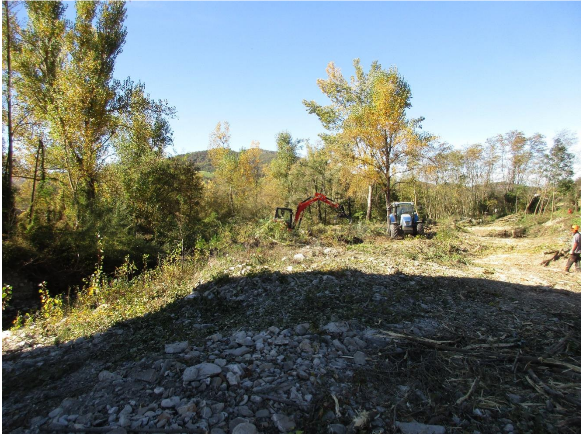
Foto 2-3 Operazioni di taglio della vegetazione arborea e arbustiva in alveo
