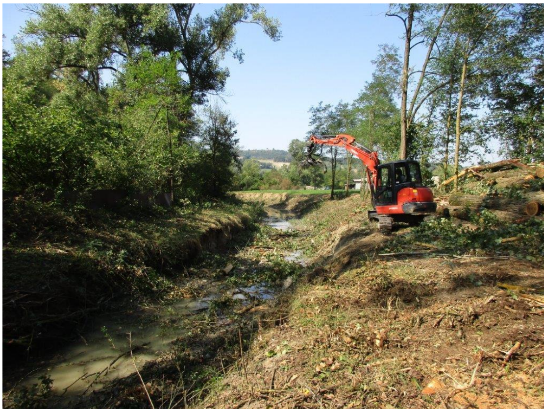
Foto 3 durante i lavori di manutenzione e pulizia
