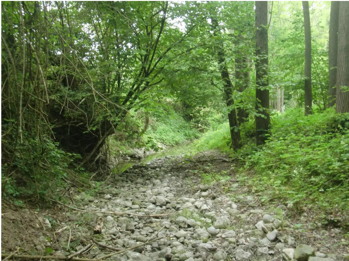
Foto 1-2 la situazione del torrente prima dei lavori
