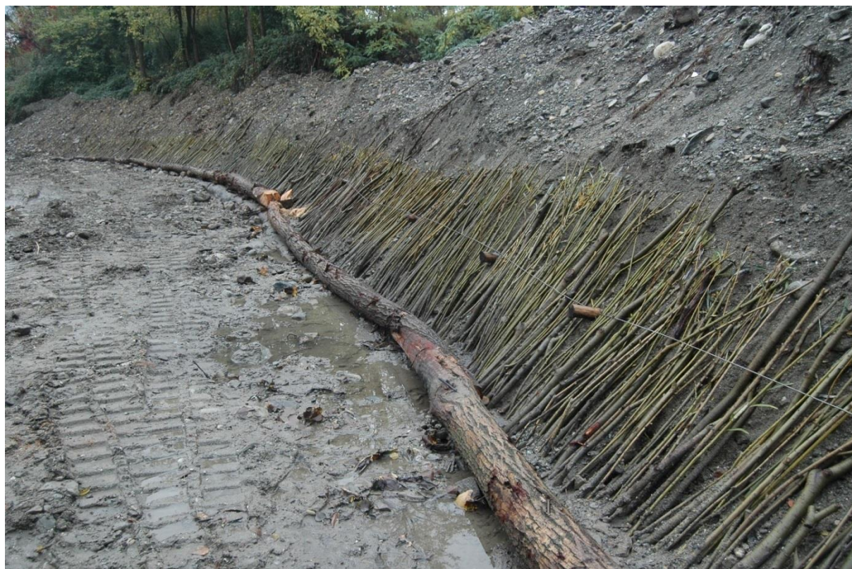
Foto 7- coperture diffuse con astoni di salice in corrispondenza dei tratti in erosione
