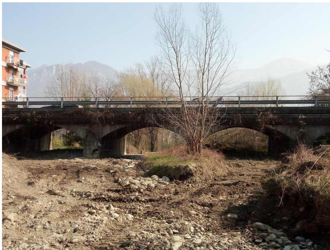
Foto 9 – lavori di riprofilazione dell'alveo in corrispondenza del ponte SP72
