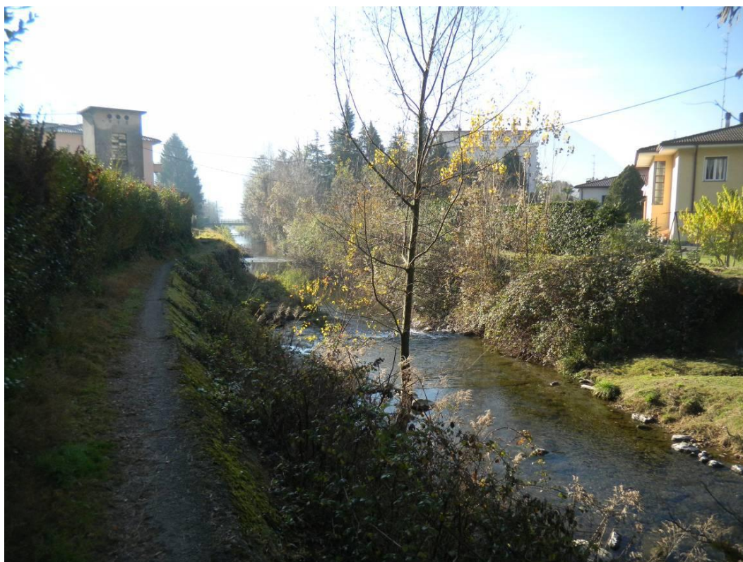
Foto 2 – torrente Rezzo, tratto urbano interessato dall'intervento di contenimento della vegetazione
