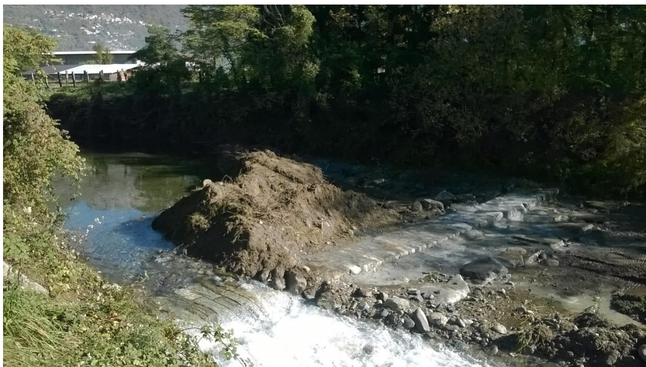
Fig. 10 – lavori di sistemazione della briglia danneggiata
