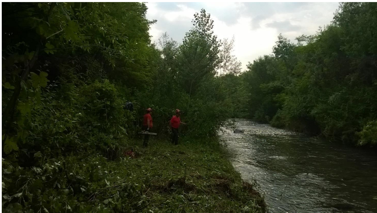
Fig. 9 – taglio della vegetazione nei tratti più stretti dell'alveo torrentizio
