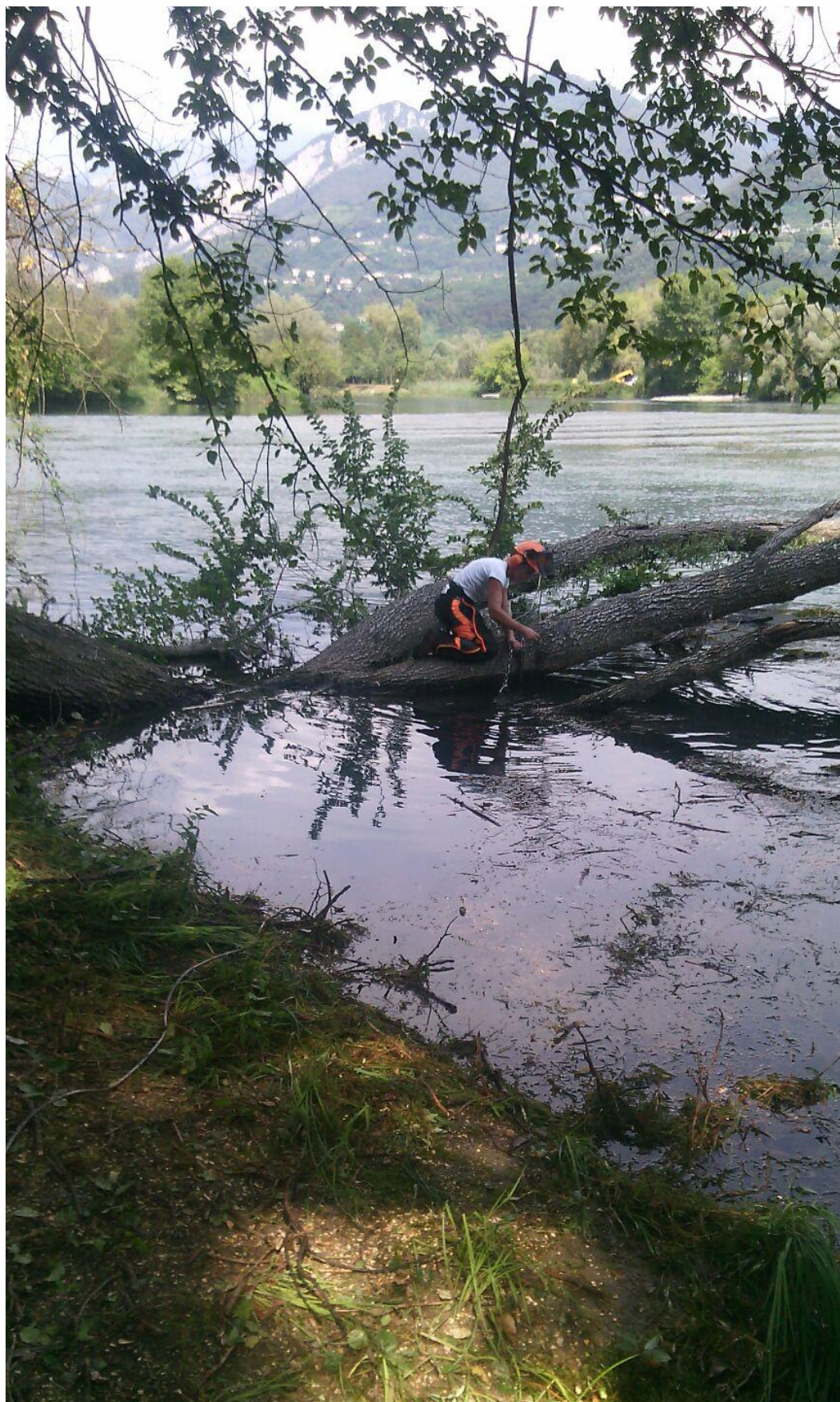
Foto 1 – asportazione di piante schiantate in alveo
