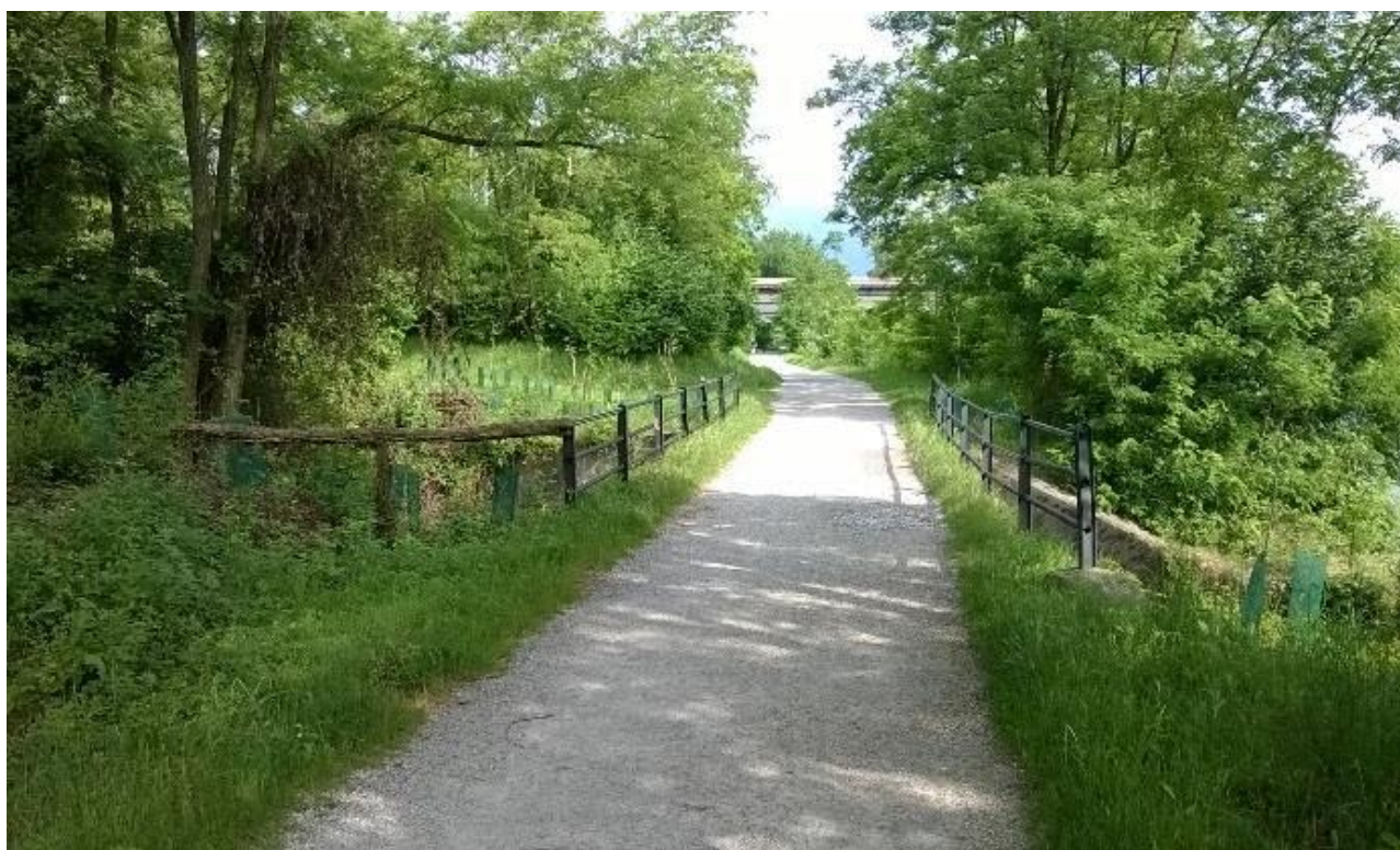
Fig. 6 – sistemazione delle ringhiere dell'attraversamento e messa a dimora di piantine
