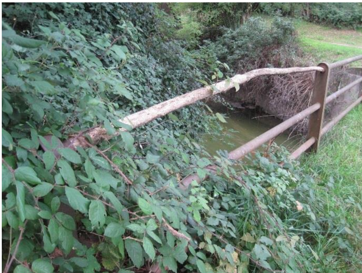
Fig. 5 – condizione iniziale dell'attraversamento sul torrente Greghentino
