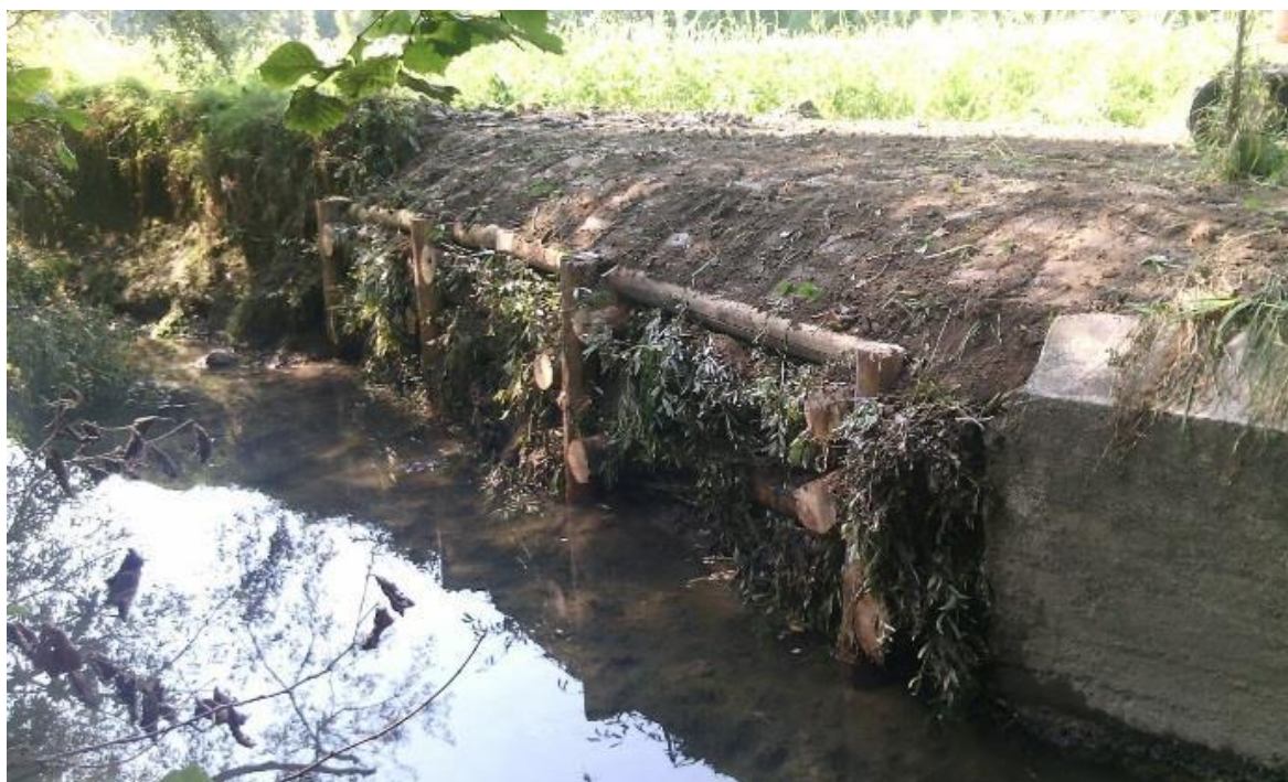
Fig. 8 realizzazione di palificata spondale a contenimento dell'erosione
