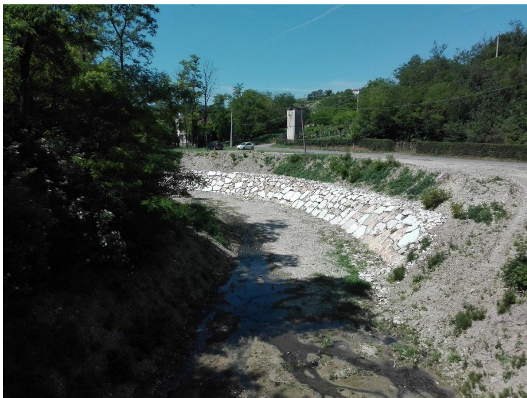
Loc. Palazzina – pulizia delle sponde, effettuata in amministrazione diretta, risezionamento dell'alveo e successiva opera di difesa spondale in appalto
