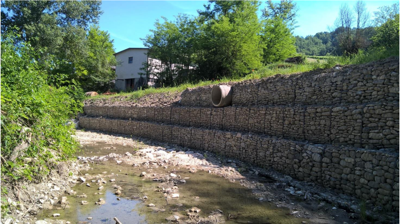
Loc. Casone – gabbionata di contenimento spondale
