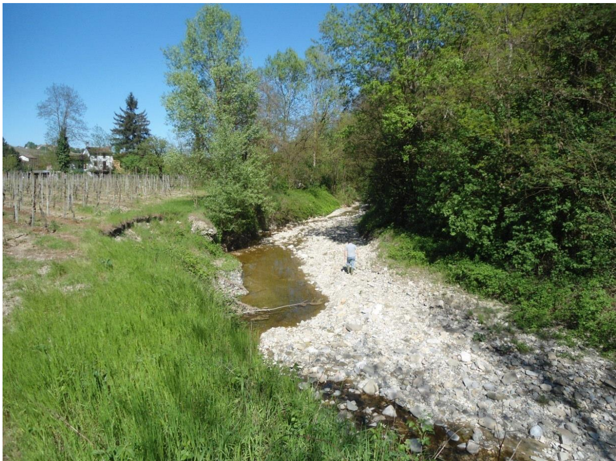
Loc. Campolungo – accumuli di materiale sul fondo dell'alveo in prossimità della curva interessata dal cedimento spondale
