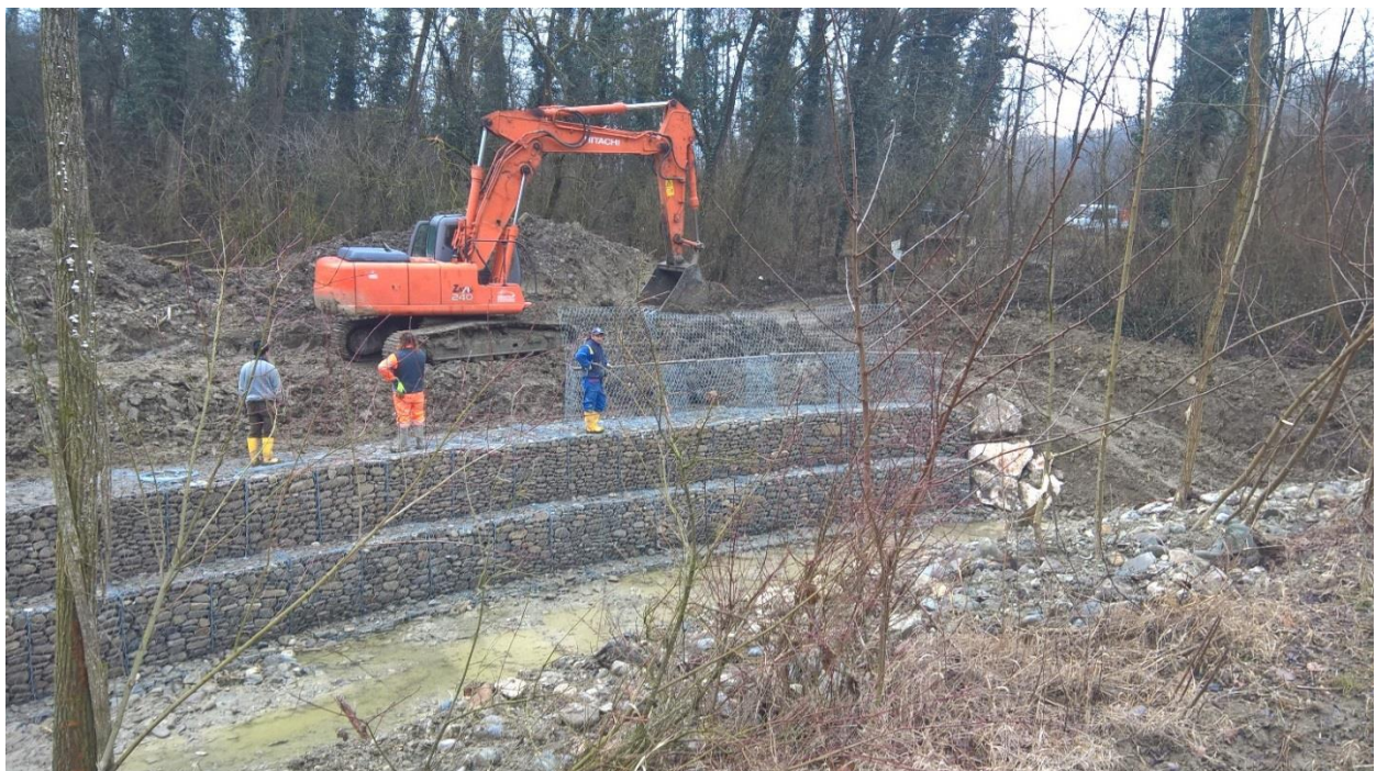
Loc. Casone – realizzazione di gabbionata di contenimento spondale
