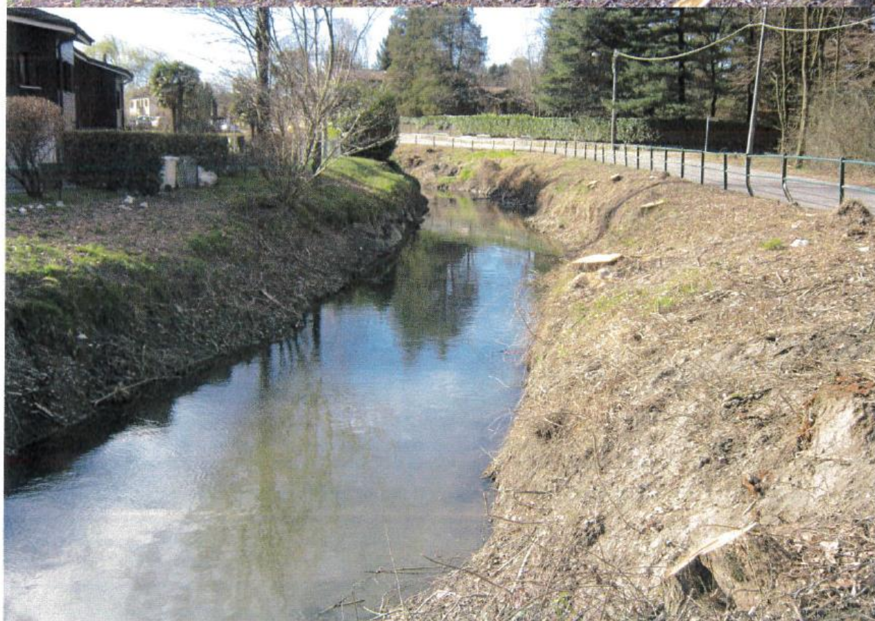
Lo stato di fatto a lavori conclusi
