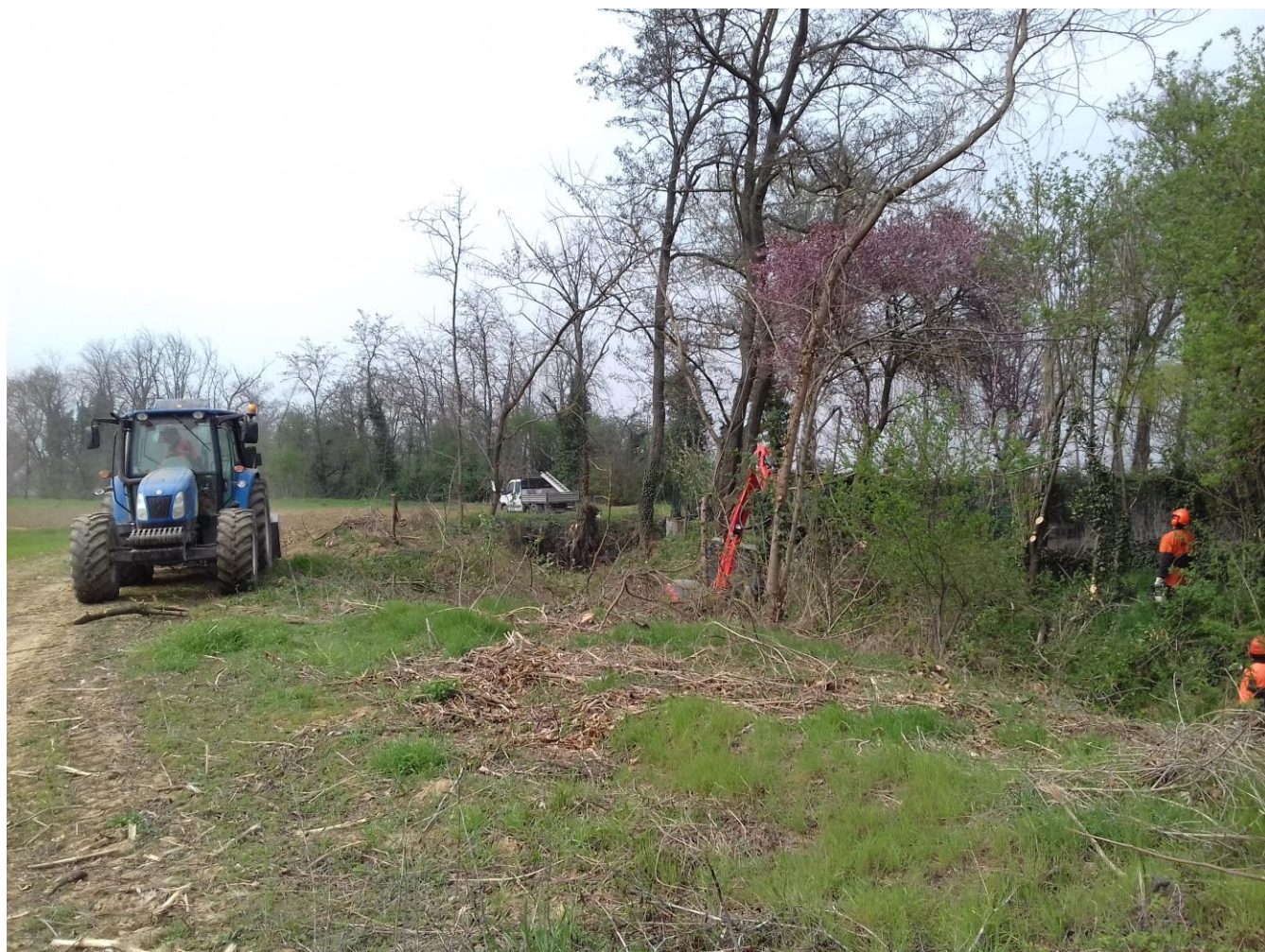
Rivanazzano Terme – Cascina Spagnola. Esecuzione intervento di taglio
