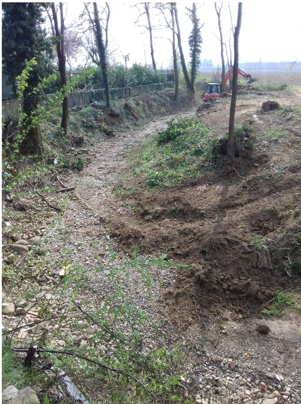
Rivanazzano Terme – Case nuove. Intervento di taglio in corso
