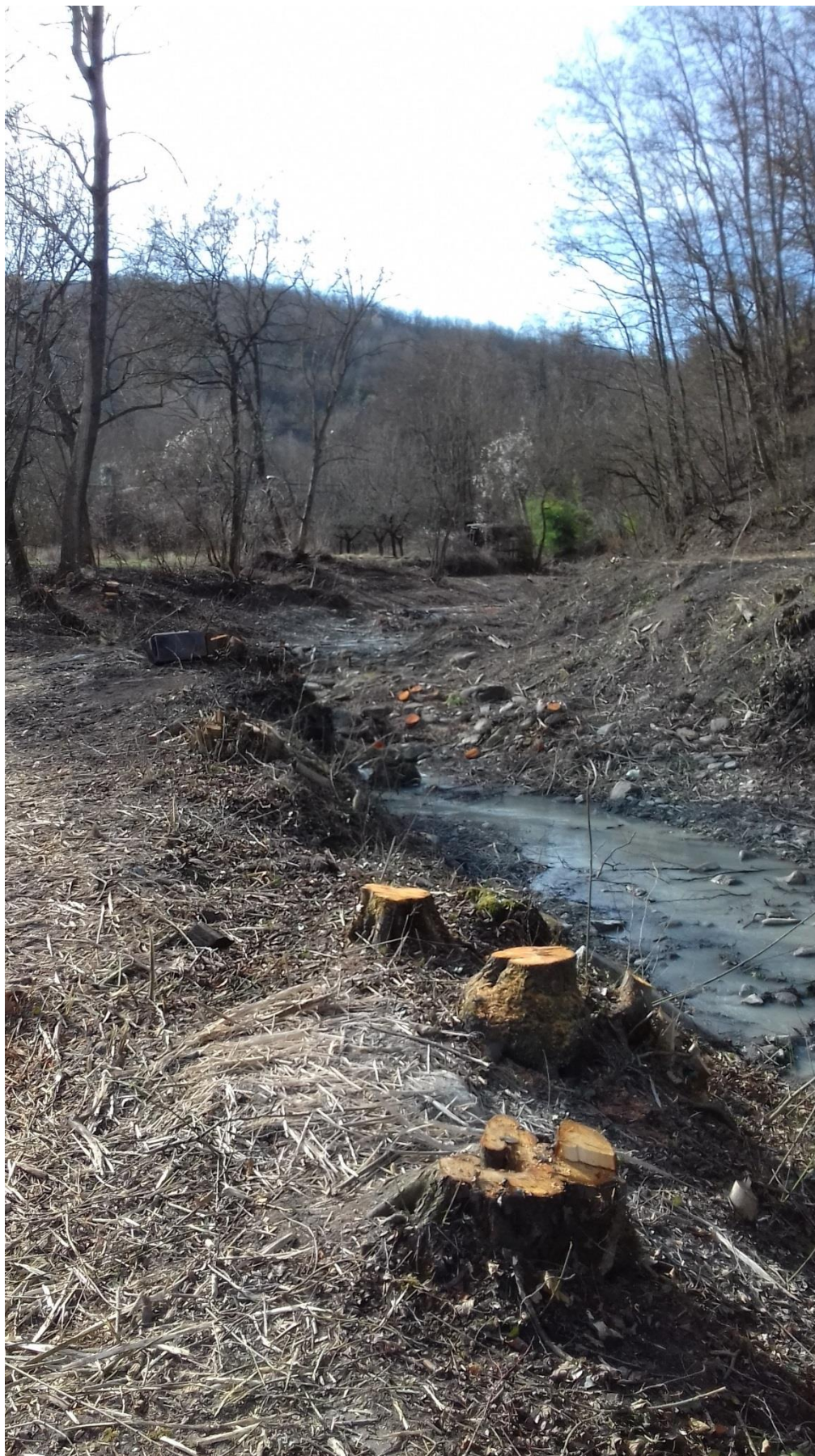
Loc. San Michele – lavori di taglio ultimati
