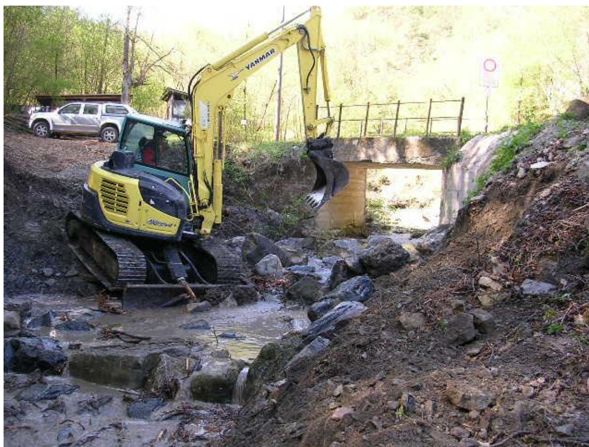
Località Braia di Cella – sistemazione scogliera
