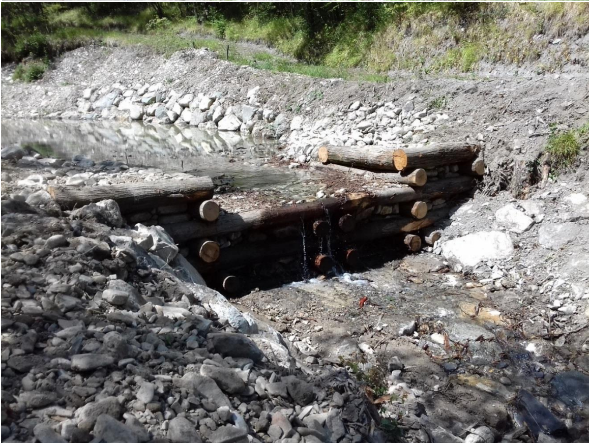
Località Braia di Cella – briglia a monte del ponte
