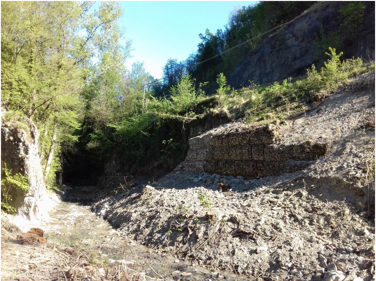
Grotte del Diavolo – manutenzione gabbionata
