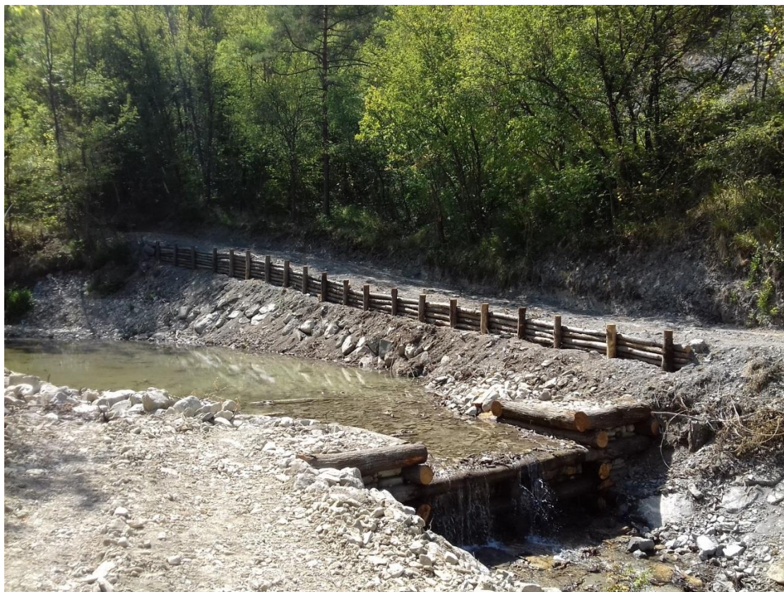
Località Braia di Cella – palificata e nuova briglia ultimate
