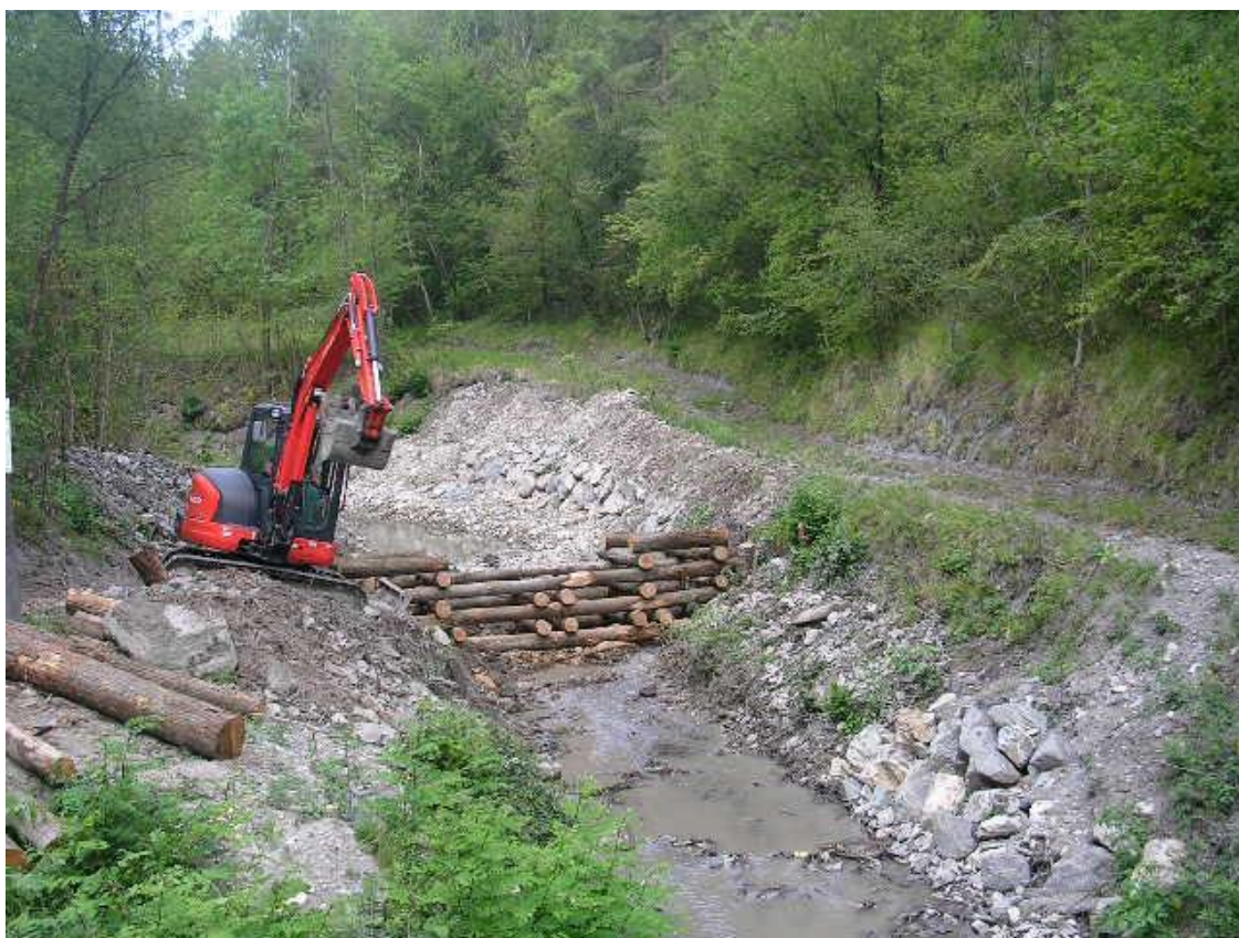
Località Braia di Cella – realizzazione briglia
