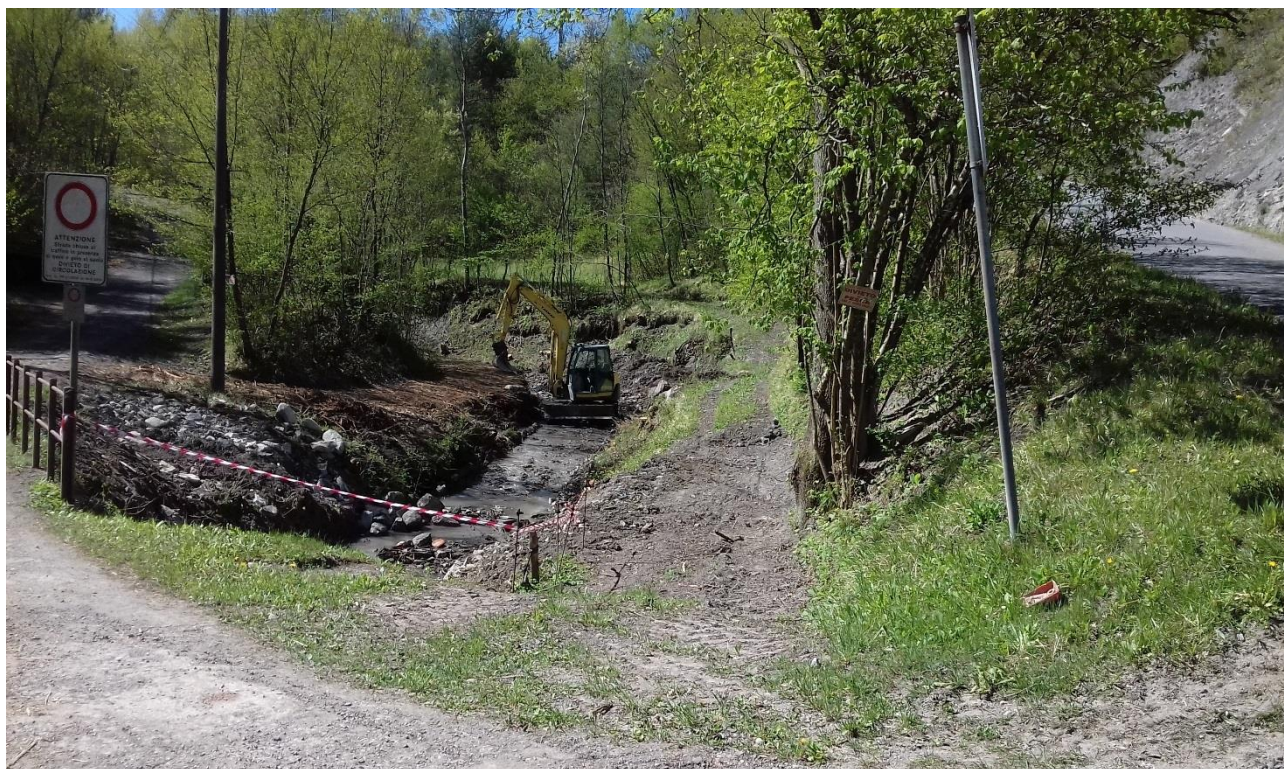
Località Braia di Cella – durante i lavori
