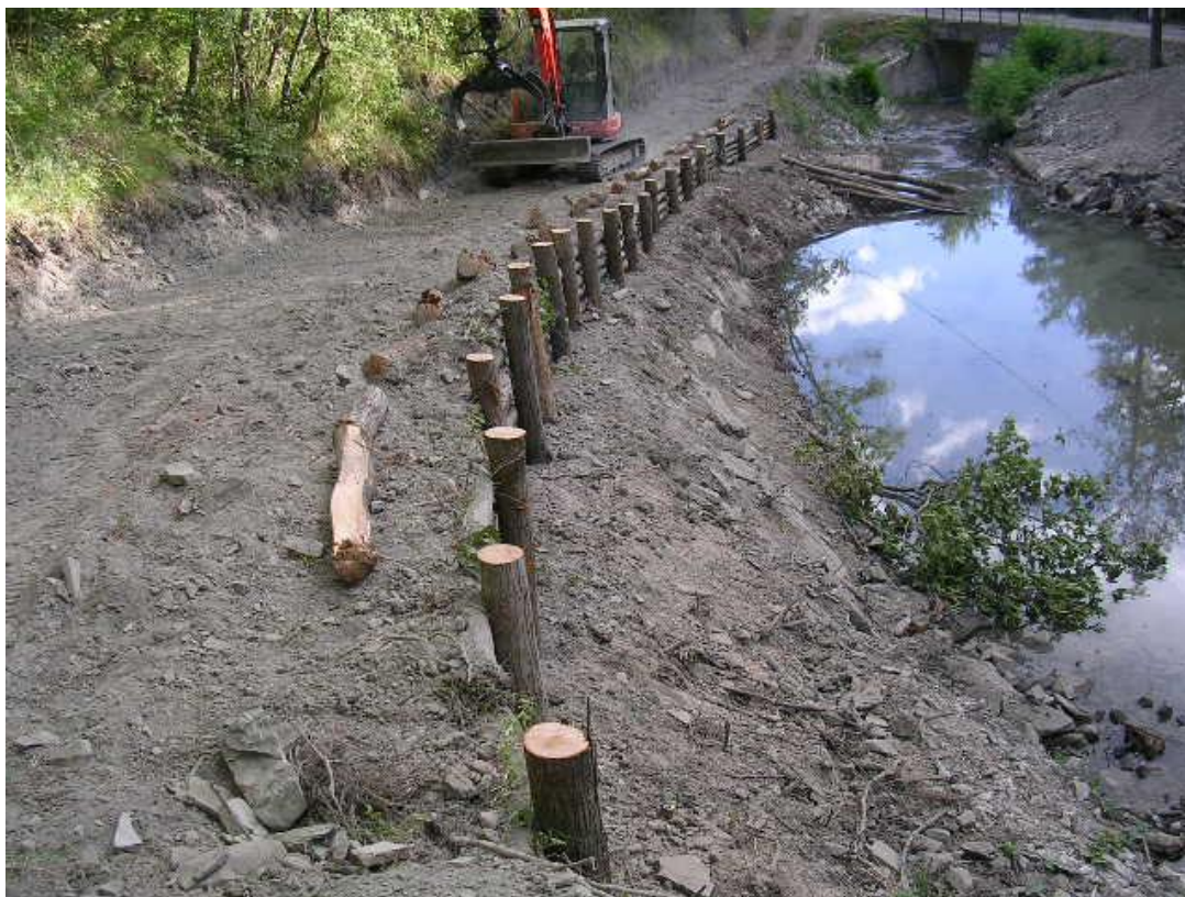
Località Braia di Cella – realizzazione nuova palificata in legno
