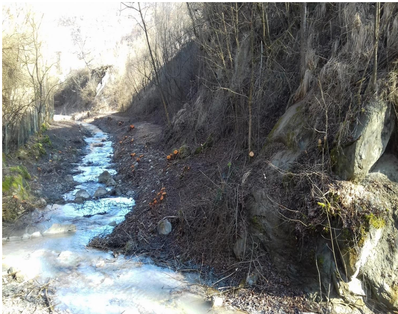
Loc. Nivione - lavori di taglio ultimati
