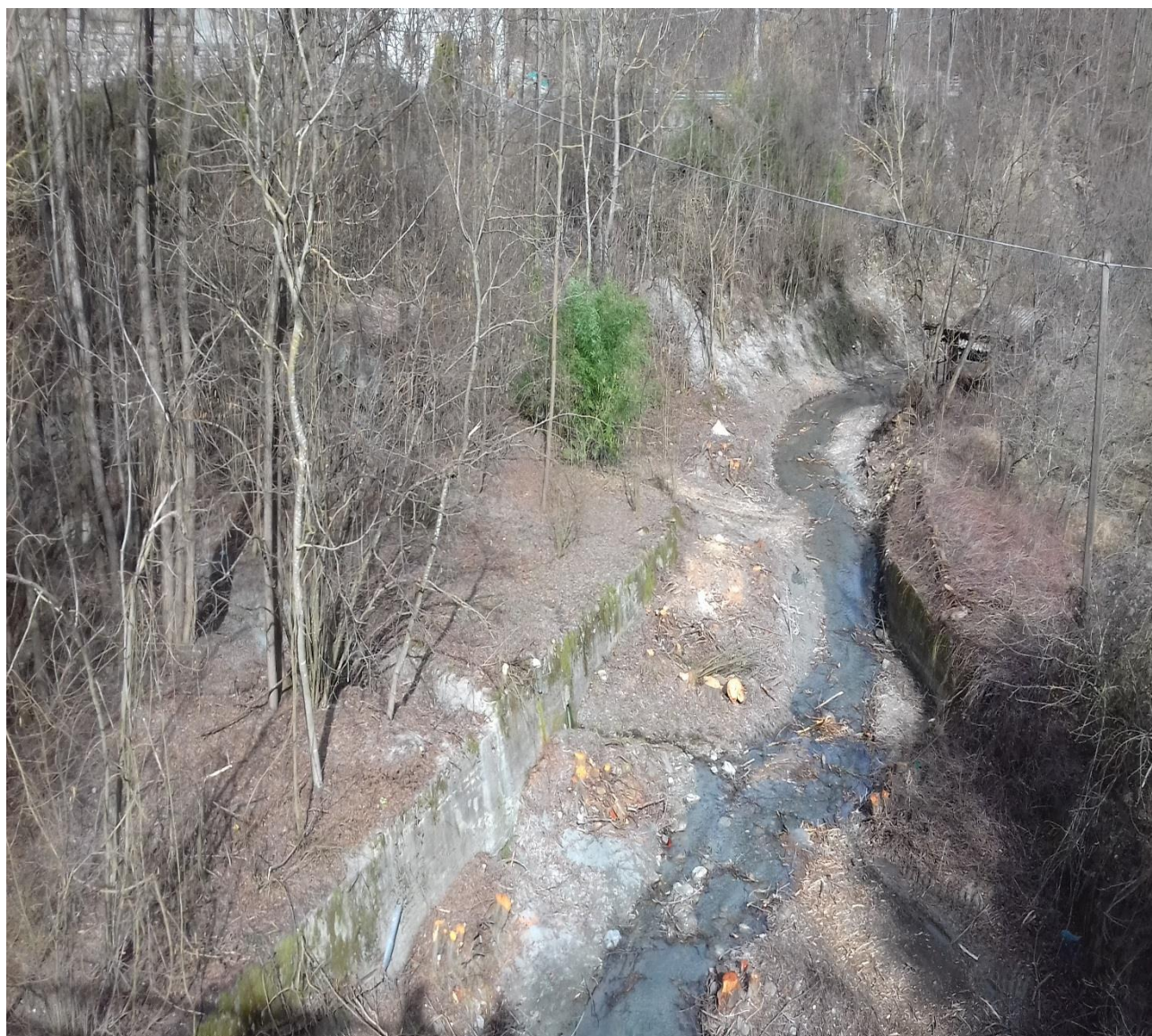
Loc. San Michele – lavori di taglio ultimati
