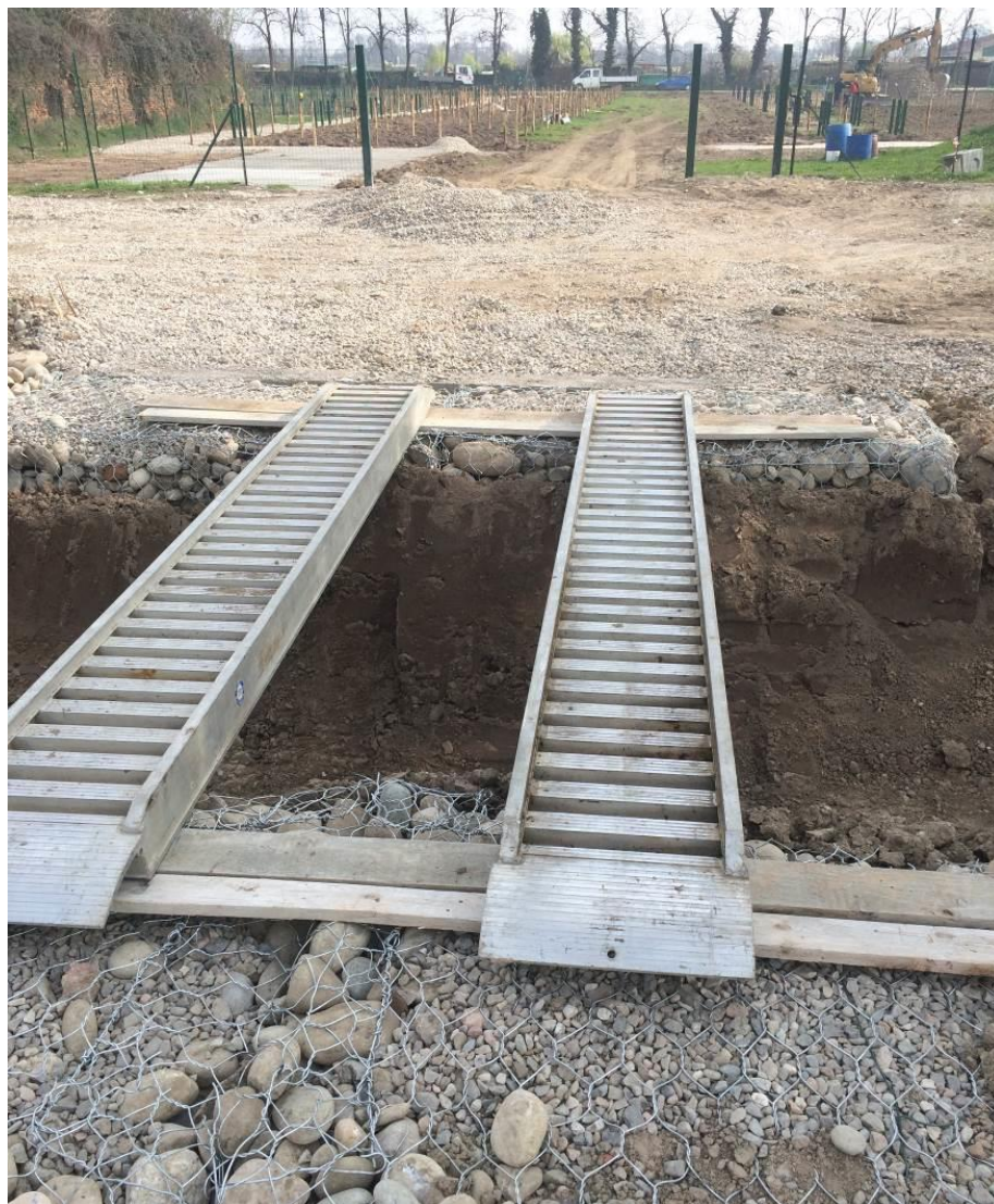
Canale irriguo sui cui è stata realizzata la passerella
