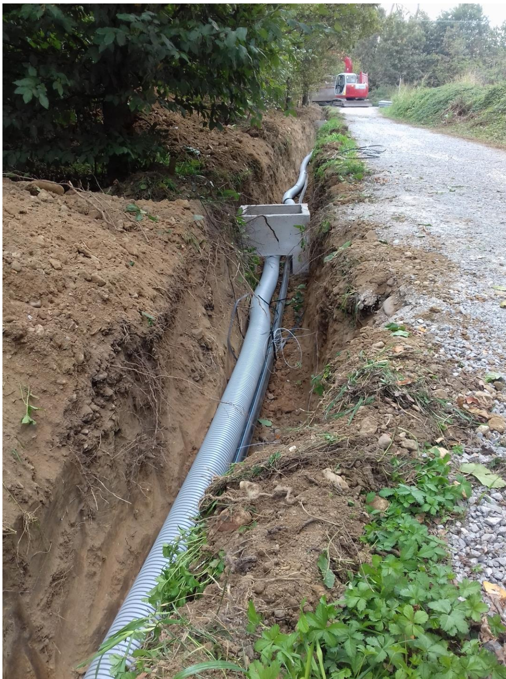
Rho – scavo per rete elettrica ed idrica
