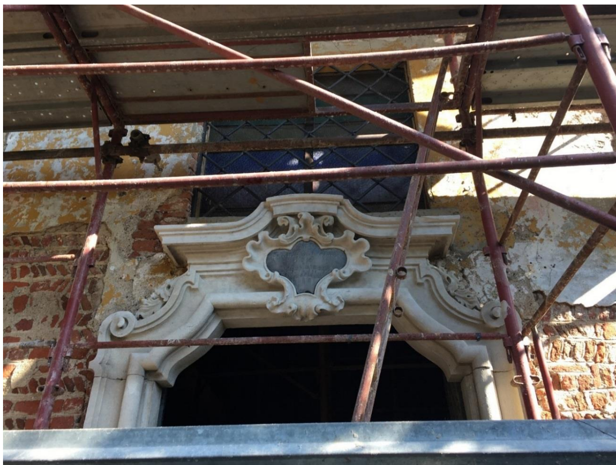
Fig. 10 - il portale durante le fasi di sistemazione
