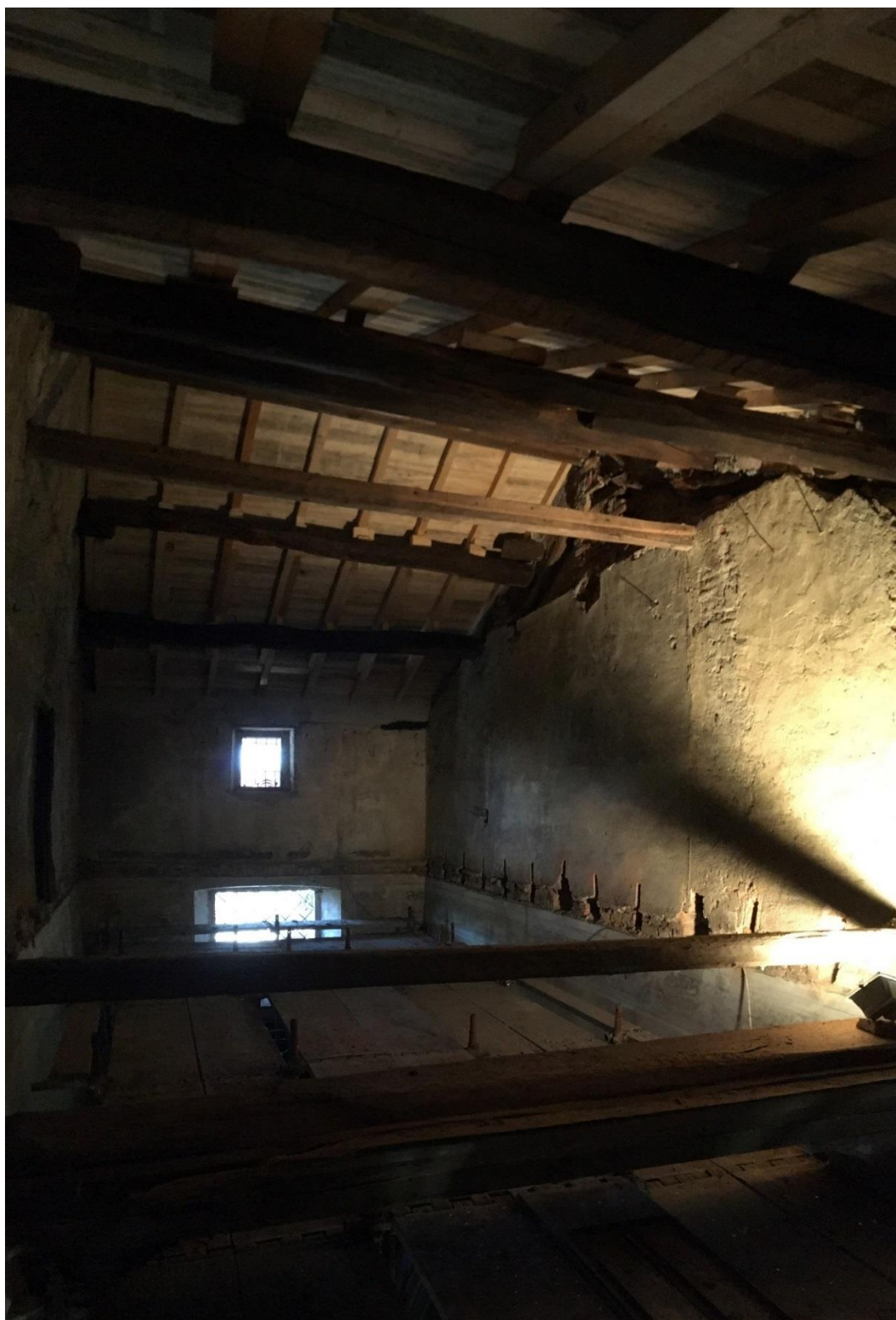
Fig. 12 -13 sistemazione del solaio
