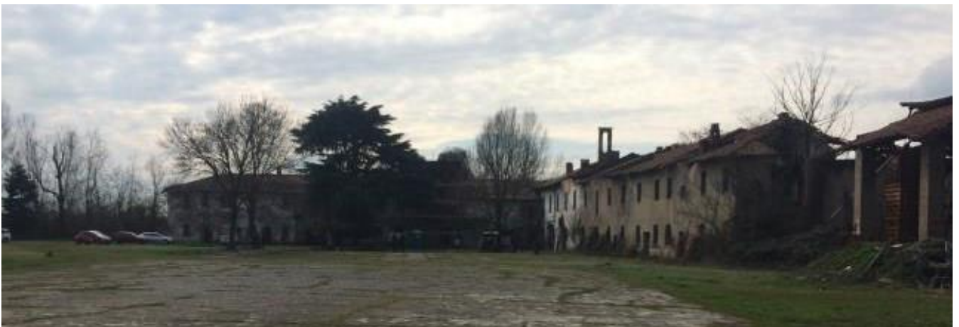
Fig. 2 - Vista dalla corte della cascina verso la Chiesa
