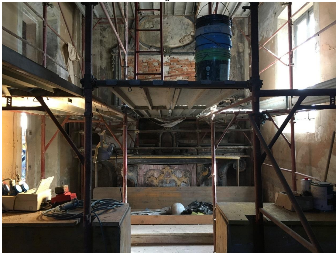
Fig. 14 interno della chiesetta durante i lavori
