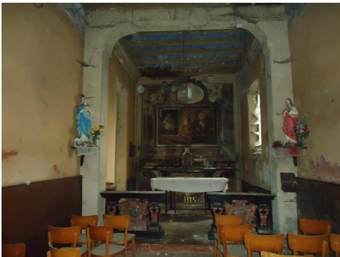
Fig. 6 - vista interna della chiesetta, prima dei lavori
