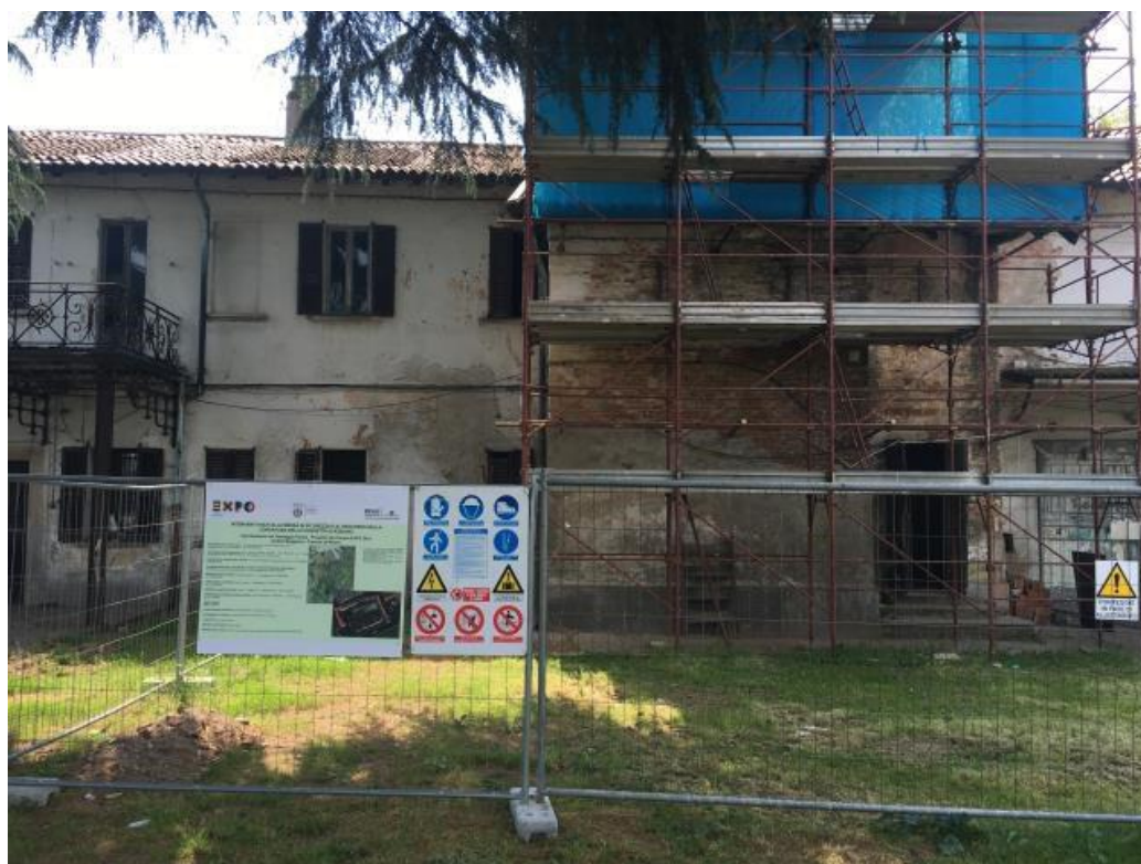
Fig. 4 e 5 - montaggio del ponteggio esterno
