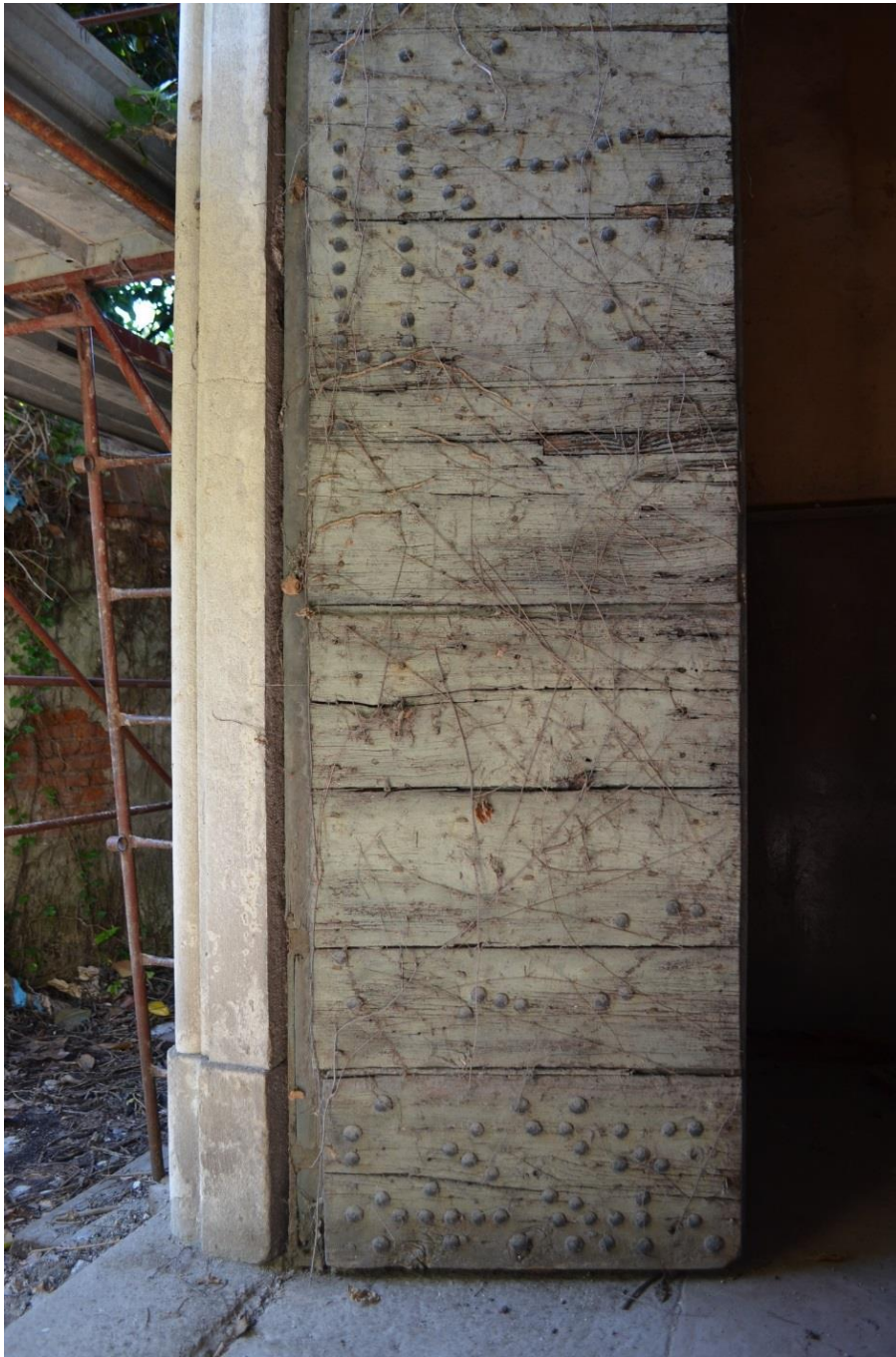
Fig. 11 - Il portone esterno coperto di vegetazione
