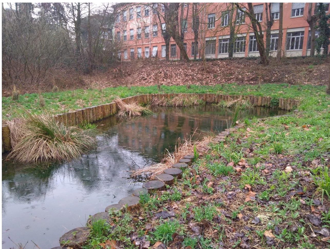
Testa di fontanile compresa nelle manutenzioni
