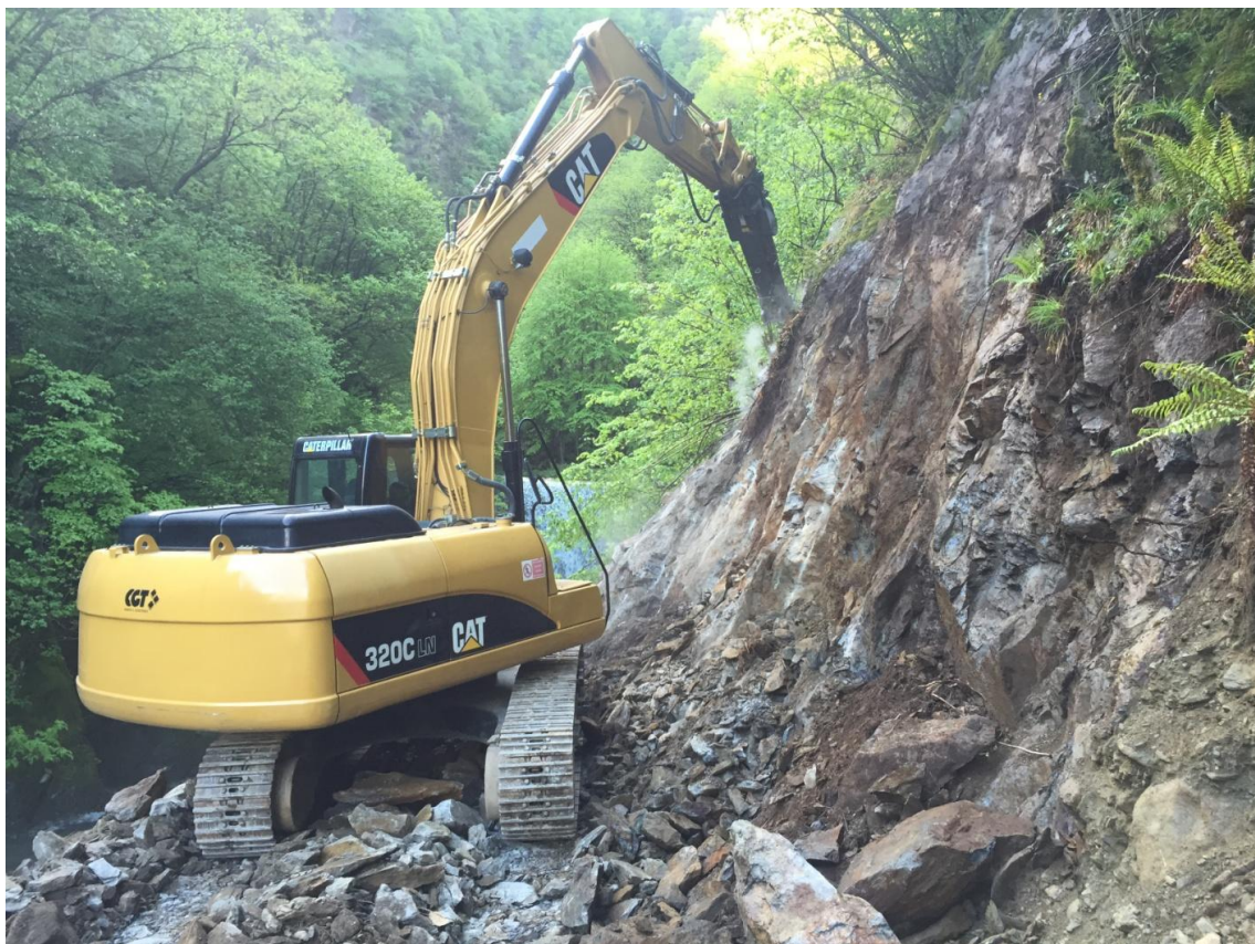
Demolizioni in roccia per formazione pista d'accesso
