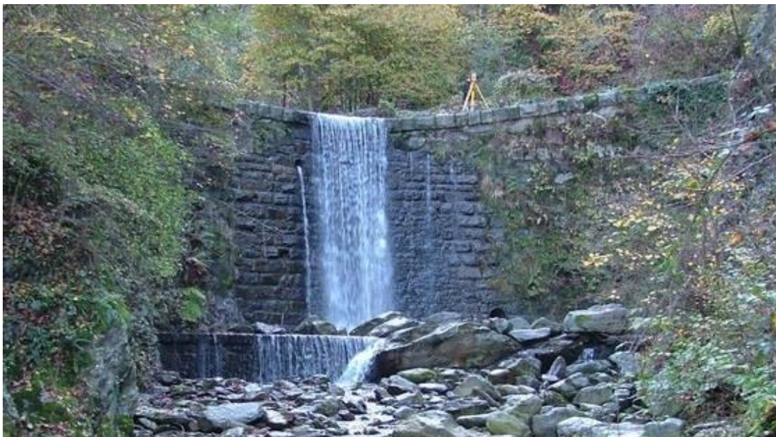
Struttura da demolire con recupero massi di rivestimento
