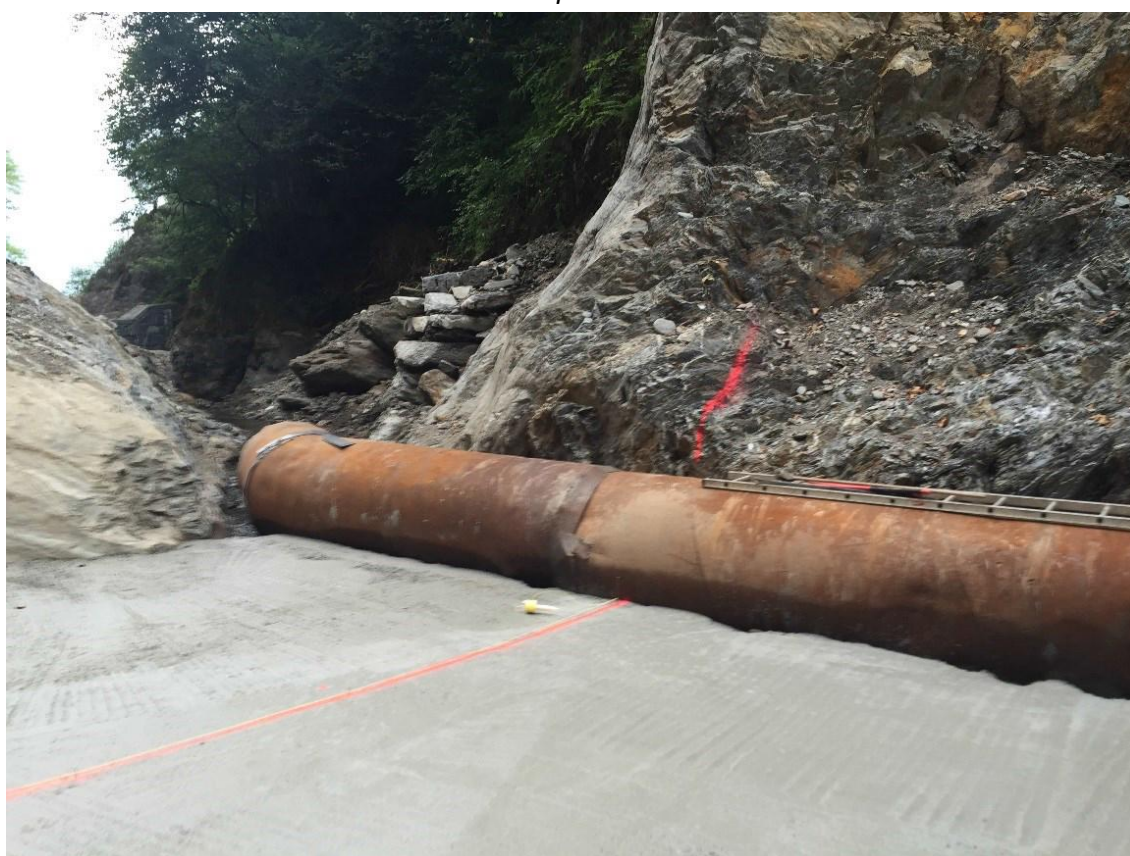
Deviazione provvisoria acque torrente Lesina
