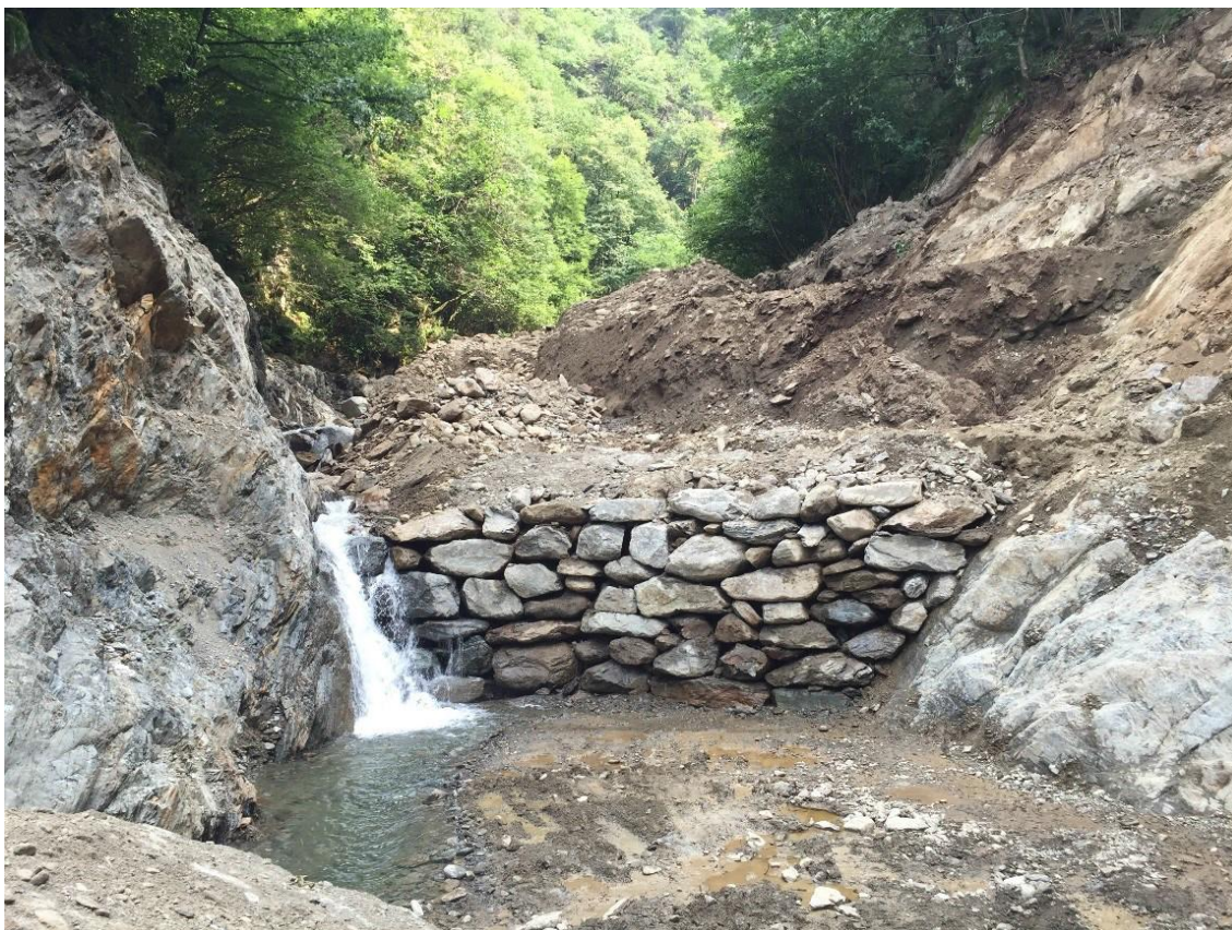
Opere provvisorie realizzate su indicazioni dello STER di Sondrio
