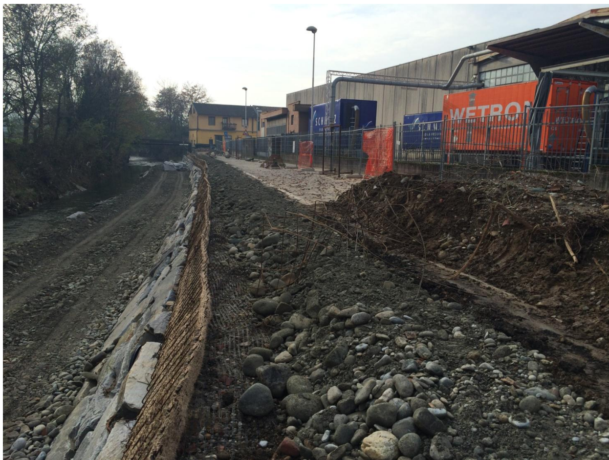
Foto 9. Sullo sfondo è visibile la passerella di attraversamento.
