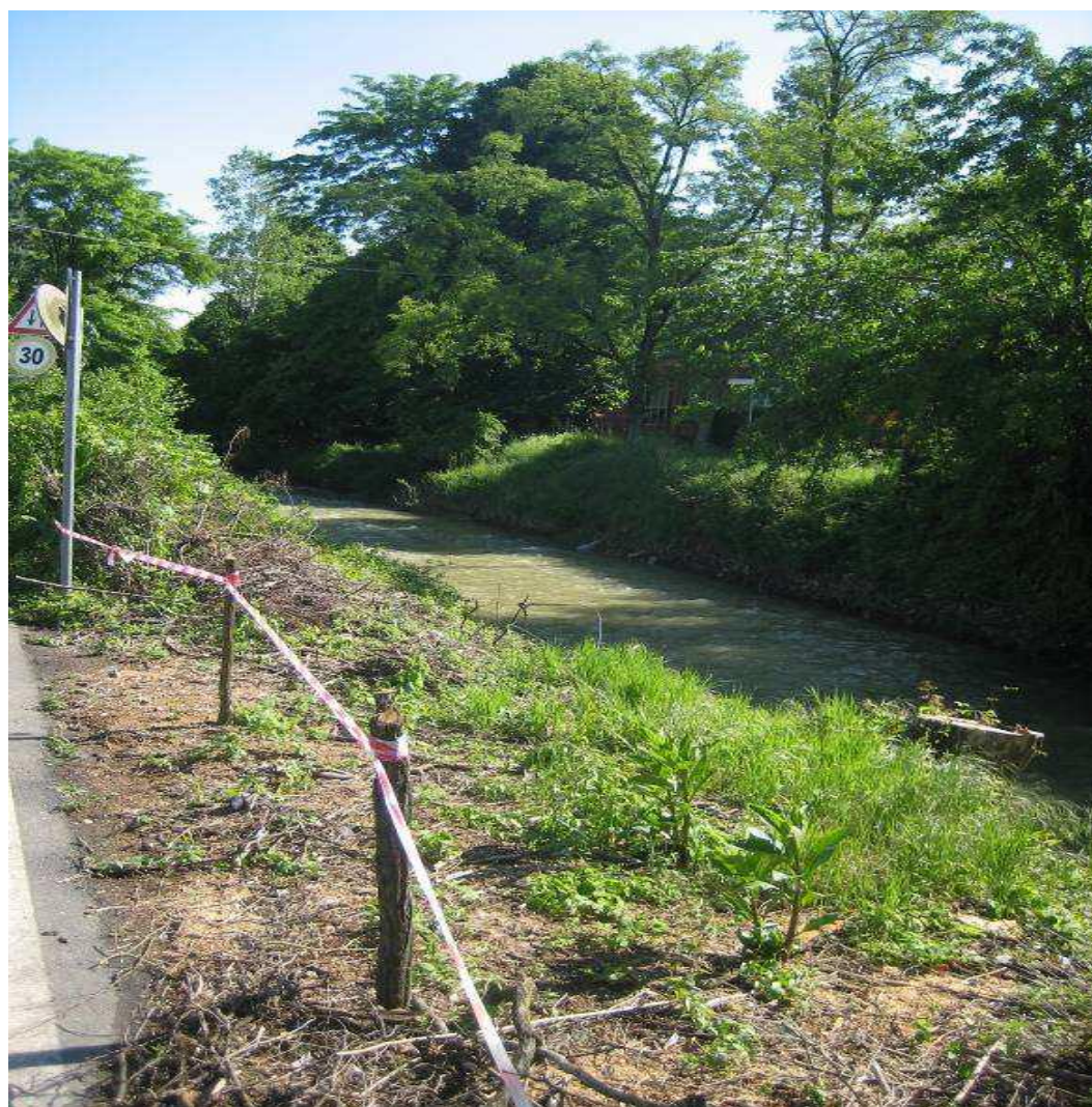
Foto 6. Tratto interessato da un'incipiente erosione di fronte all'ingresso carraio della ditta Trocellen.
