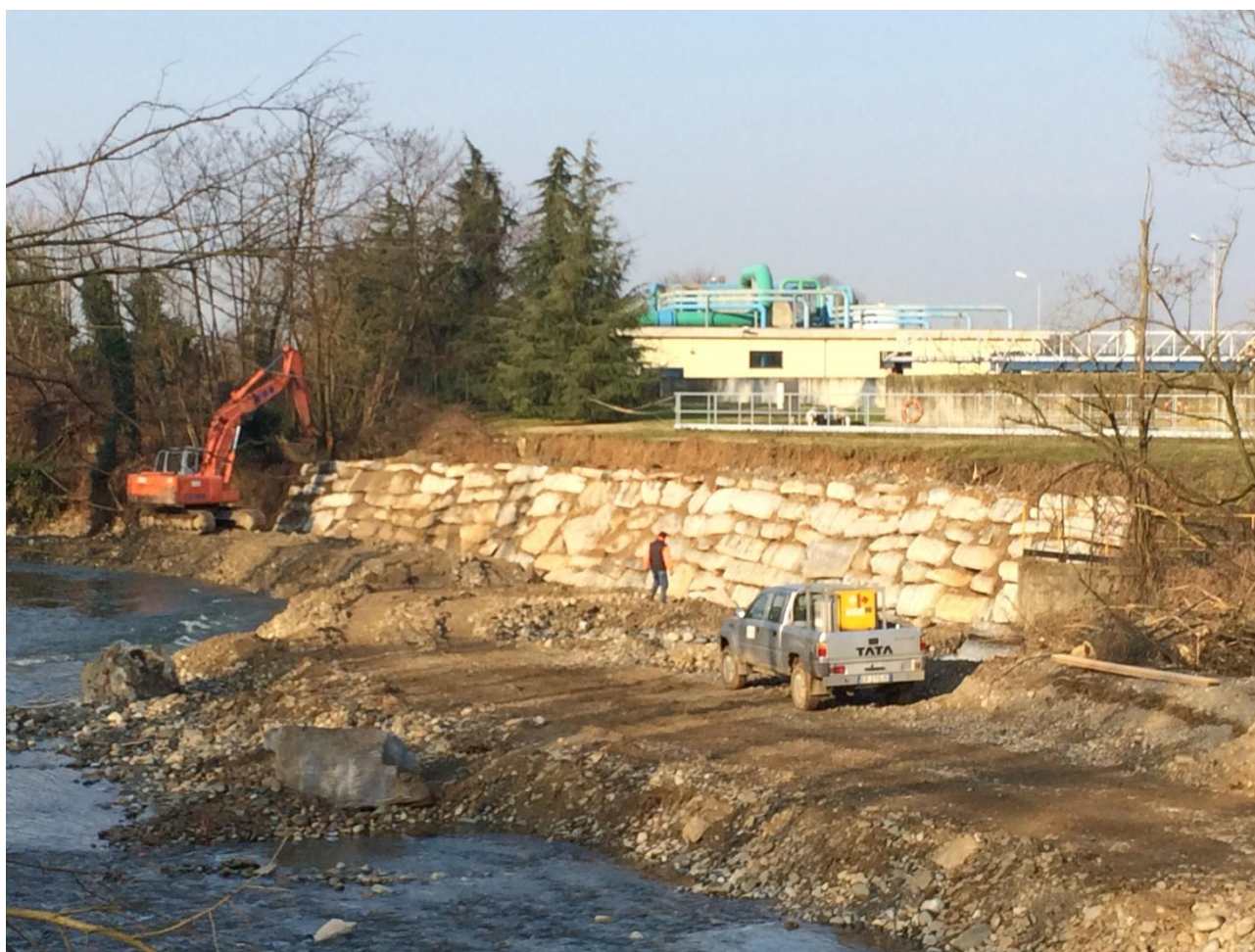
Foto 3. Posa di massi ciclopici a difesa della sponda; sullo sfondo è visibile il depuratore.
