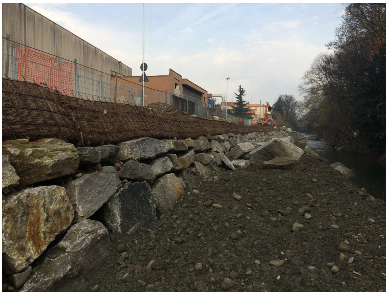
Foto 8. Posa dei massi ciclopici.
