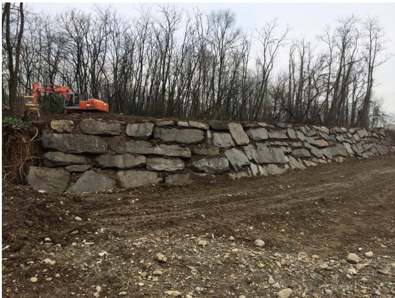
Foto 4. Ultimazione della posa di massi ciclopici lungo il tratto spondale.
