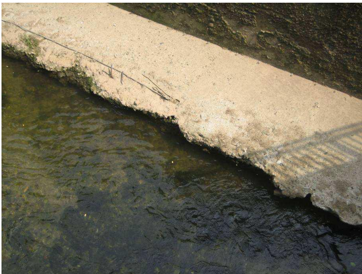
Foto 11. Ciabatta di fondazione completamente esposta lungo lo stesso tratto.
