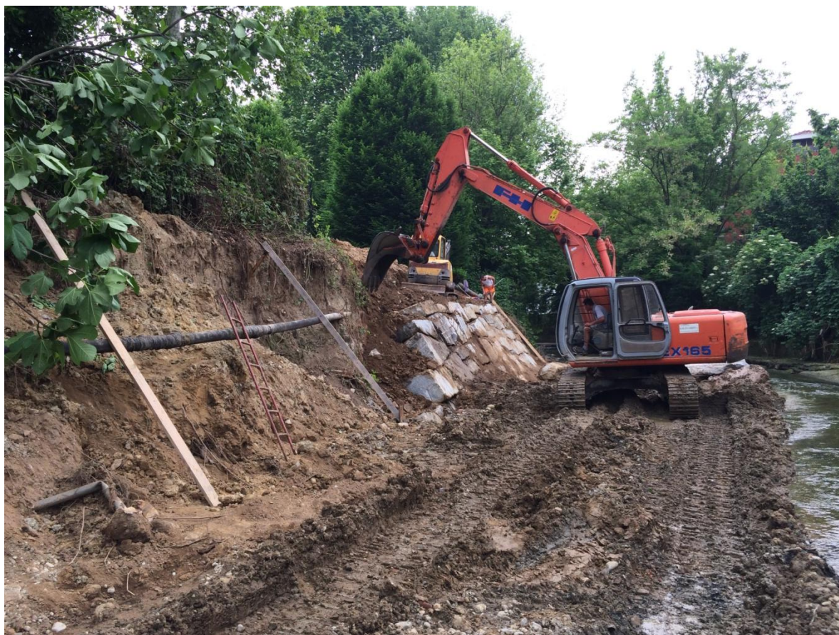
Foto 12. I lavori di ricostruzione della sponda a Melzo.
