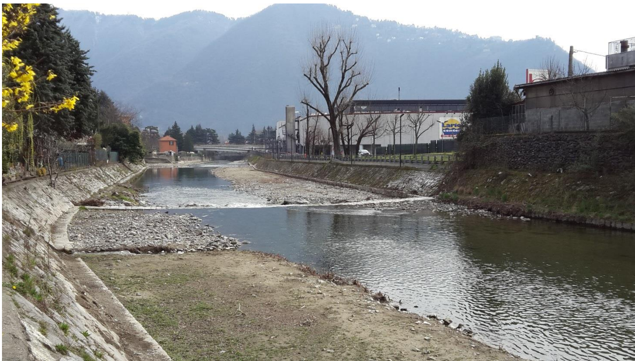
Rimozione dei depositi presenti lungo entrambe le sponde, riprofilatura dell'alveo e attività di decespugliamento.
