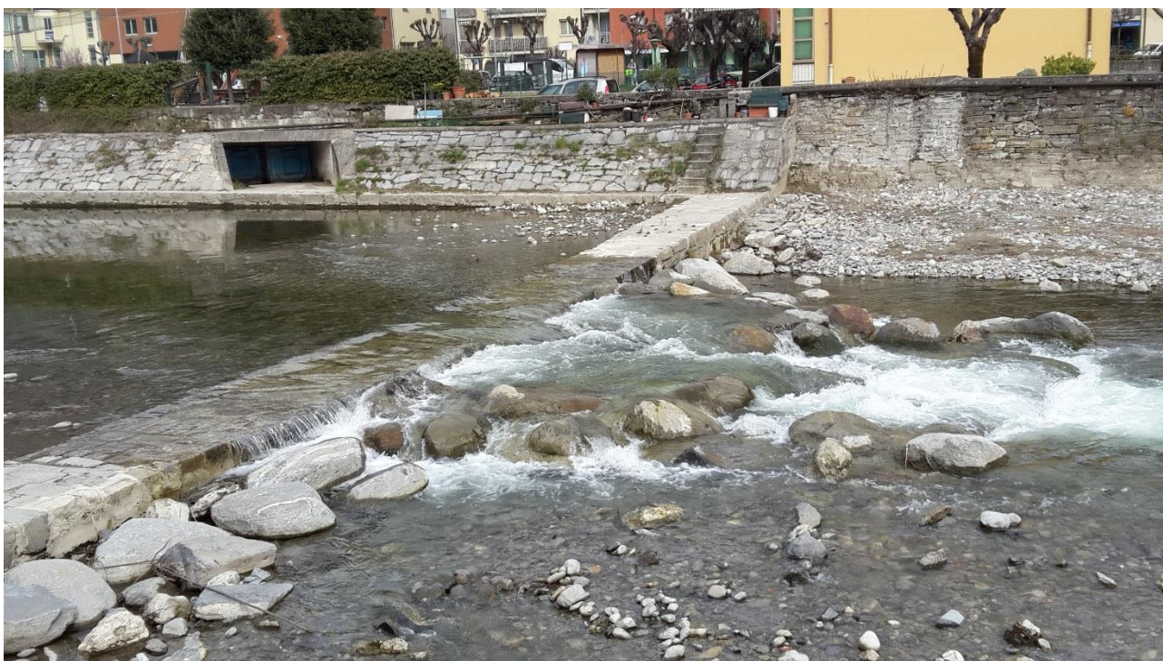
Opere di sistemazione della briglia e realizzazione di una rampa di risalita per i pesci con pietra e malta cementizia con uso di conci di pietra regolari.
