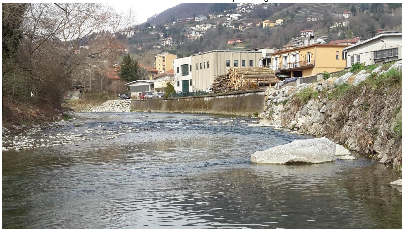
Realizzazione di due tratti di scogliera in sponda sinistra, lungo Via Caronti nel Comune di Maslianico con pietrame di cava delle Prealpi. I due tratti di scogliera si raccordano ad un argine in cemento preesistente.
