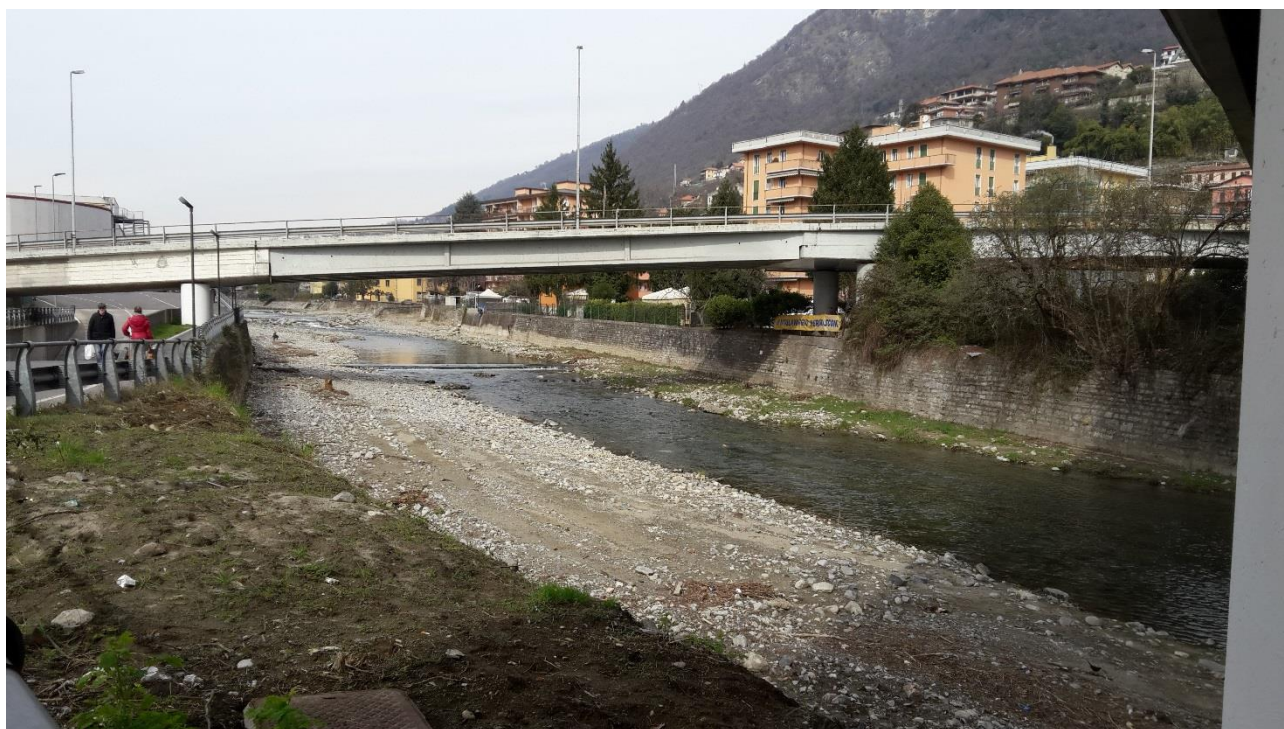
Rimozione dei depositi in sponda destra, degli orti e dei fabbricati abusivi adiacenti il Centro commerciale di Via Asiago in Comune di Como e in corrispondenza degli attraversamenti stradali.
