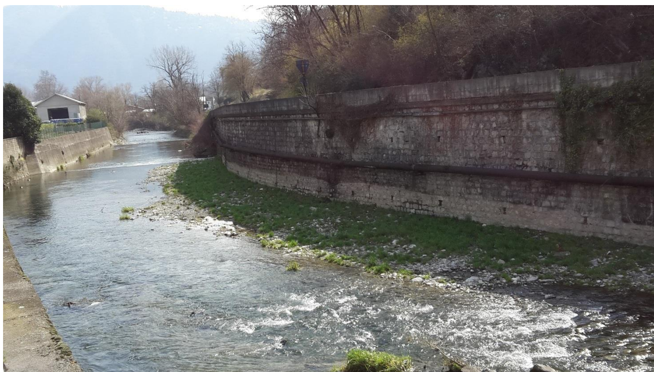
Rimozione dei depositi lungo Via Asiago nel Comune di Como
