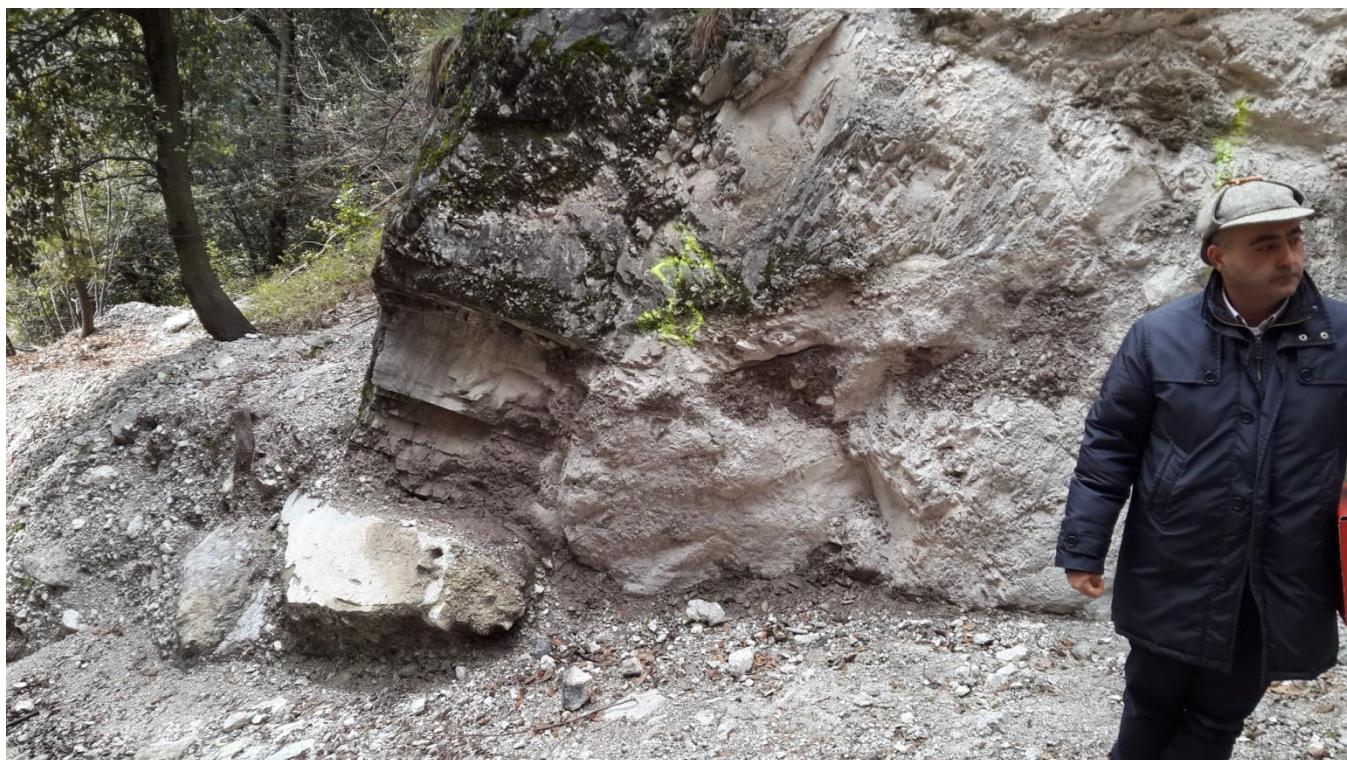
Figura 4 – Riprofilatura dell'alveo del torrente in corrispondenza dell'area di installazione della barriera n. 1
