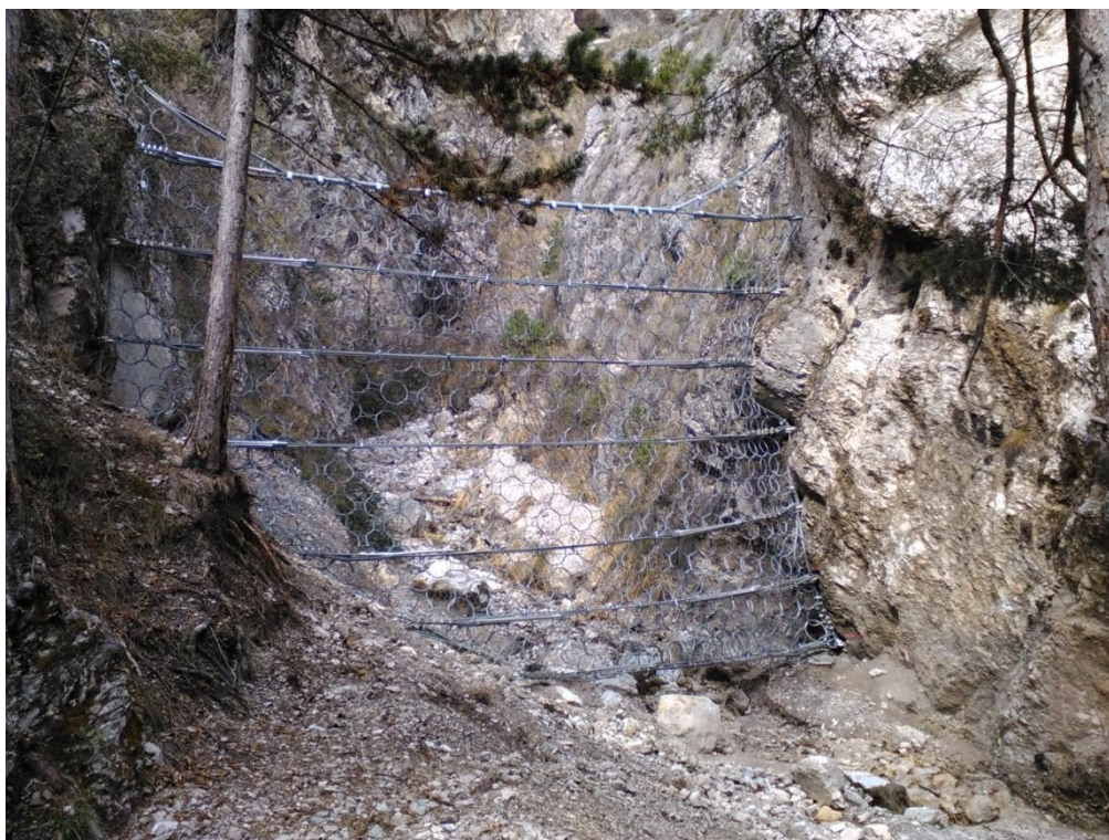
Figura 6 – Barriera di contenimento n. 2 installata in alveo a monte della barriera b. 1 – vista da valle
