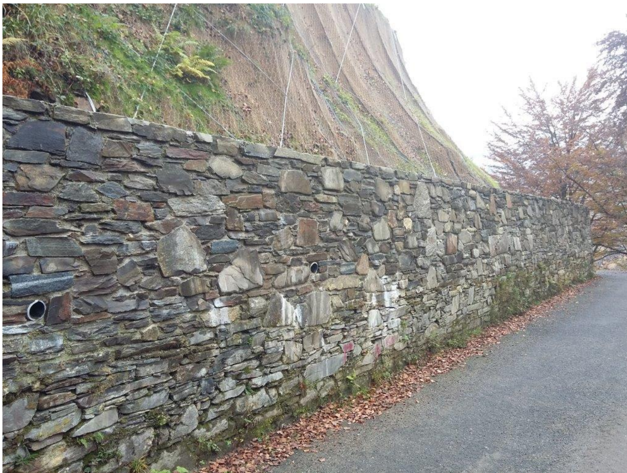
Figura 11 - in primo piano il muretto di sostegno completato
