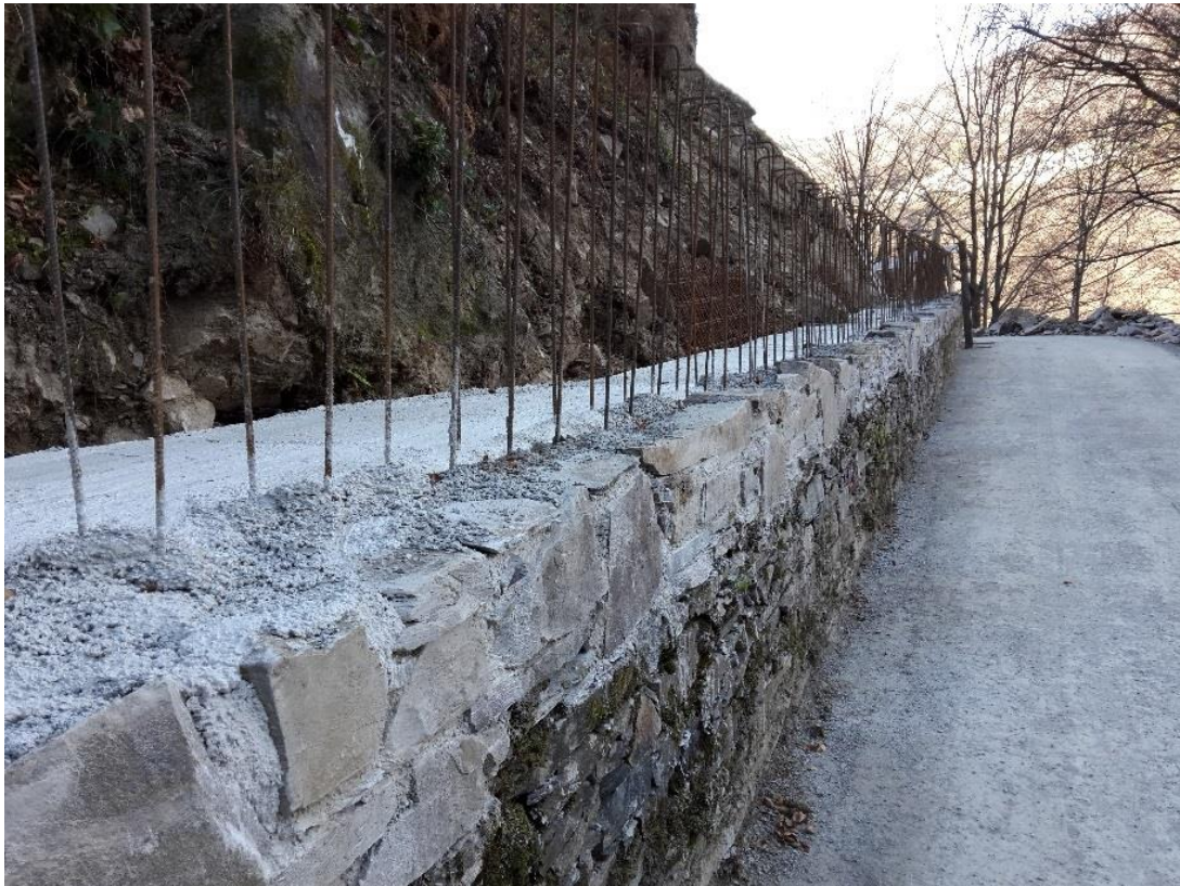
Figura 8 e 9 - particolare del momento di costruzione del muro in pietra e calcestruzzo
