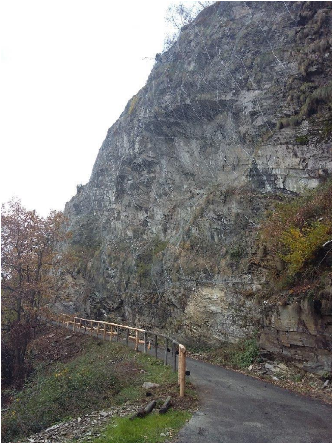
Figura 32 - reti metalliche posate
