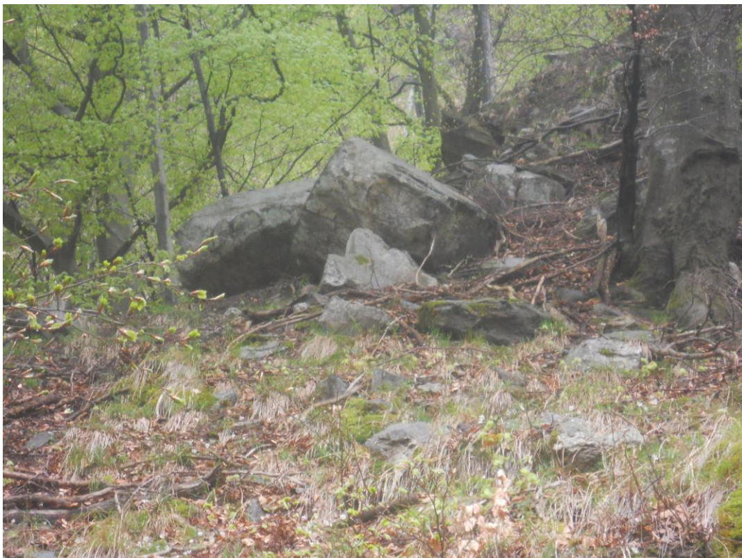
Fig.4 - seconda area di intervento, particolare dei massi in equilibrio instabile
