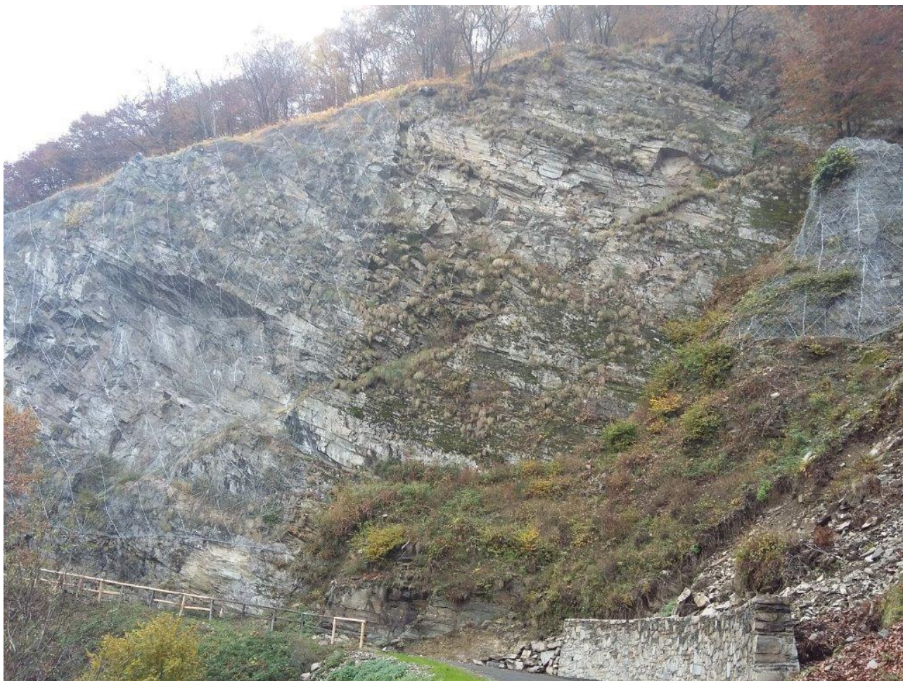
Figura 14 –posa di rete metalliche a contenimento
