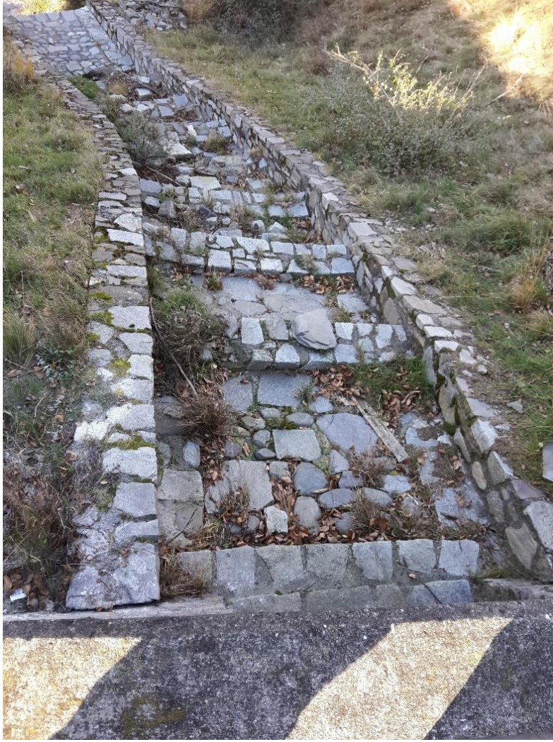
Figura 20 - particolare del canale, evidente la parte nuova a proseguimento di quella esistente
