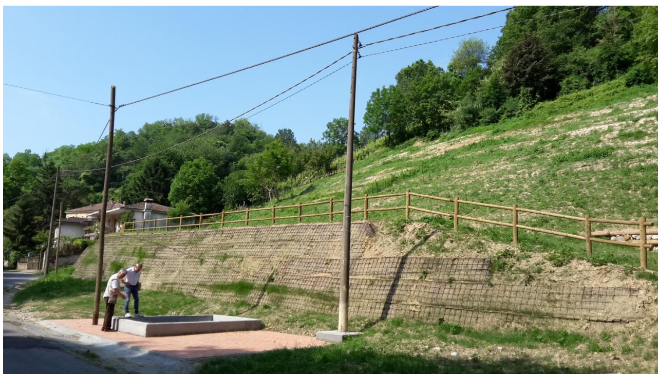
3) Vasca di raccolta acque in calcestruzzo a valle del drenaggio principale.
