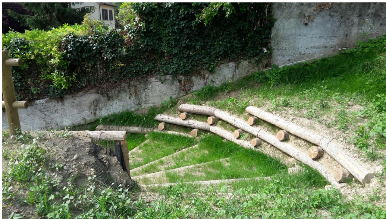
6) Scalinata rustica realizzata con pali di legno e tecniche di ingegneria naturalistica all'estremo sud della terra rinforzata per l'accesso pedonale
