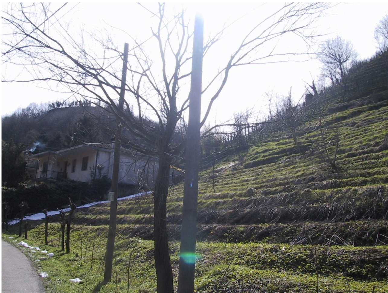
In primo piano, il versante prima dell'inizio dei lavori, sullo sfondo un vecchio vigneto
