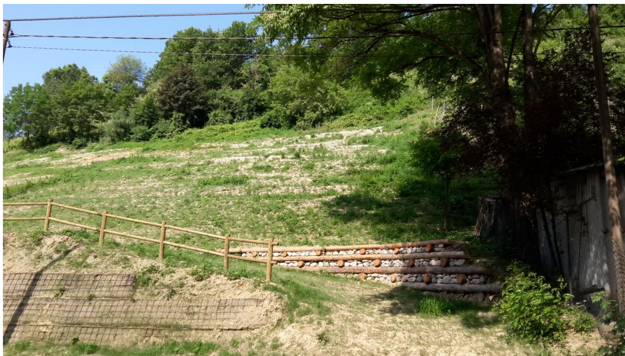
2) Consolidamento del corpo di frana e palificata in legname per proteggere le scarpate della rampa.
