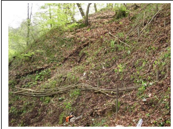
Taglio di piante su pendice prima e dopo l'intervento, con posa delle graticciate.
