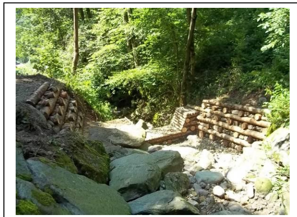
Sponda destra erosa, il medesimo punto sistemato con briglia e palificate.
