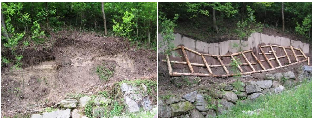
Erosione sponda destra prima e dopo la realizzazione della grata viva.
