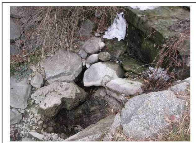
Selciato dell'alveo parte alta prima e dopo la sistemazione con massi e cemento.
