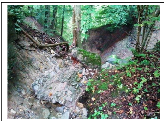
Muretto d'argine crollato e successiva sistemazione con sottomurazione.
