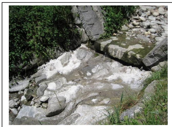
Selciato dell'alveo parte alta prima e dopo la sistemazione con massi e cemento.
