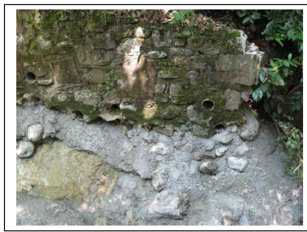
Muretto d'argine crollato e successiva sistemazione con sottomurazione.
