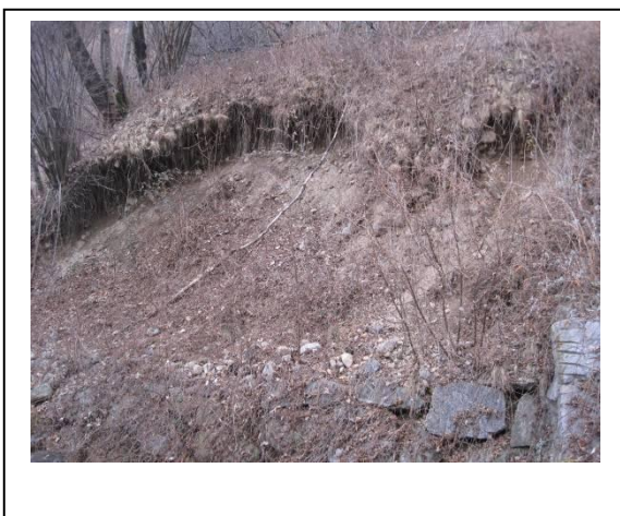
Erosione del versante destro, interventi realizzati: scoronamento, posa cordonate e juta.
