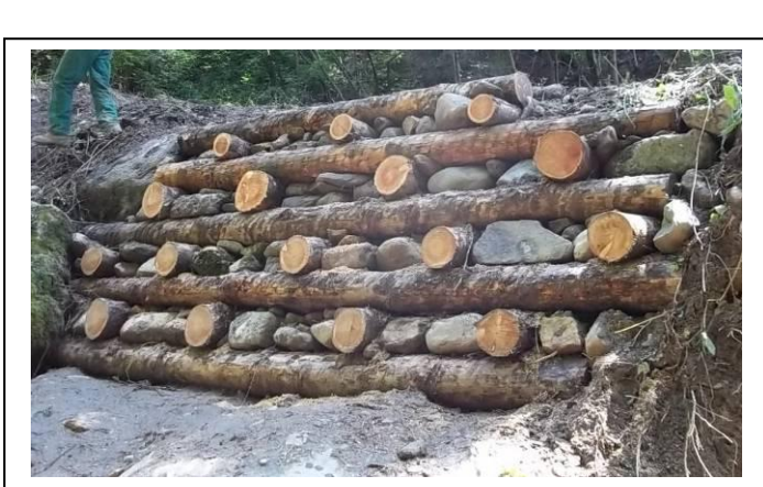
Alveo superiore prima e dopo la realizzazione della palificata di sostegno.
