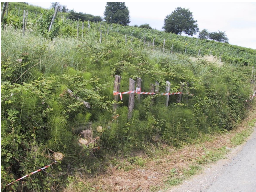
L'intervento in corso - immagini
