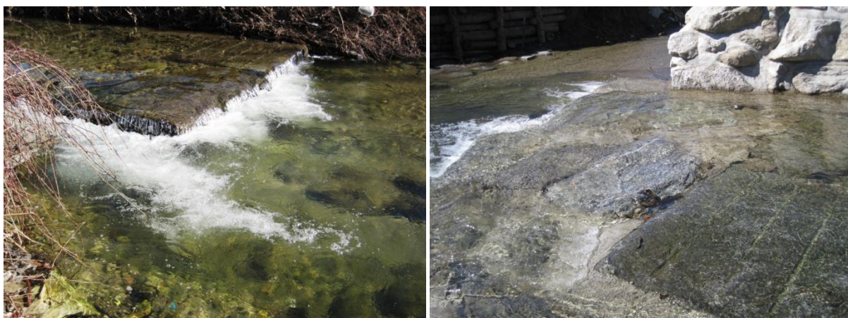
selciatoone sul fondo, prima e dopo la realizzazione
