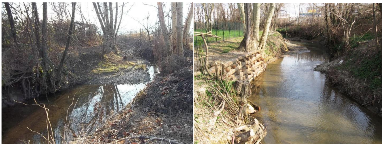
fiume Seveso, l'alveo prima e dopo la risagomatura
