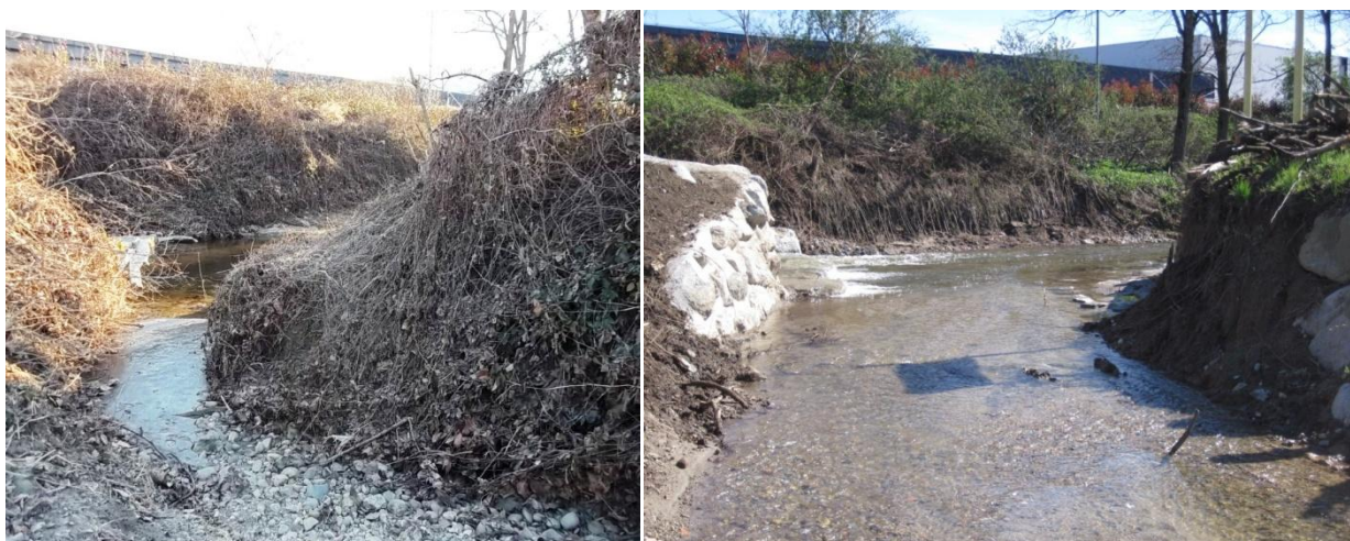
rimodellamento delle sponde fosso del Lusert, prima e dopo l'intervento
