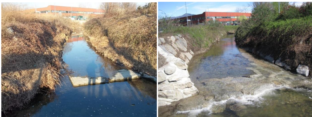
realizzazione delle due ali di gaveta, prima e dopo
