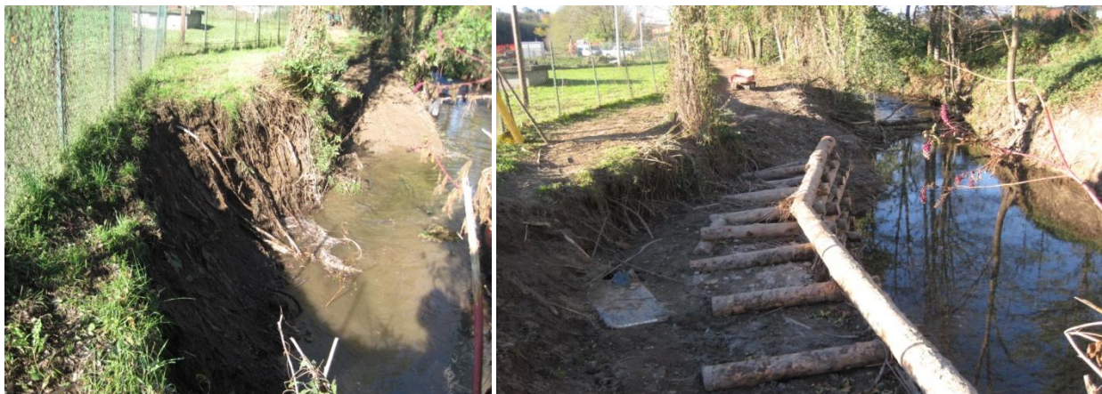
palificata semplice, prima e durante la realizzazione
