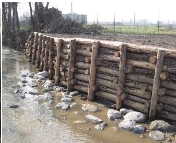
palificata spondale: situazione prima e dopo la realizzazione del manufatto
