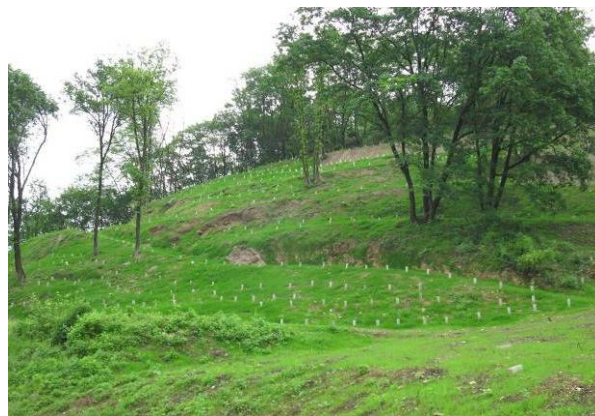
Riqualificazione in area boscata
