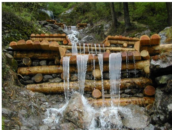
Briglia in legname e pietrame realizzata dal Consorzio Forestale Alto Serio (BG) coi fondi della misura 226 – Foto Adriano Pasini
